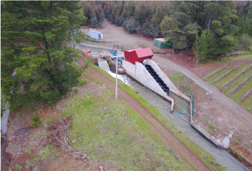
**Fig. 4.18 – Tornillo Arquímedes Central Alto La Viña Canal Biobío Sur – Chile.**
