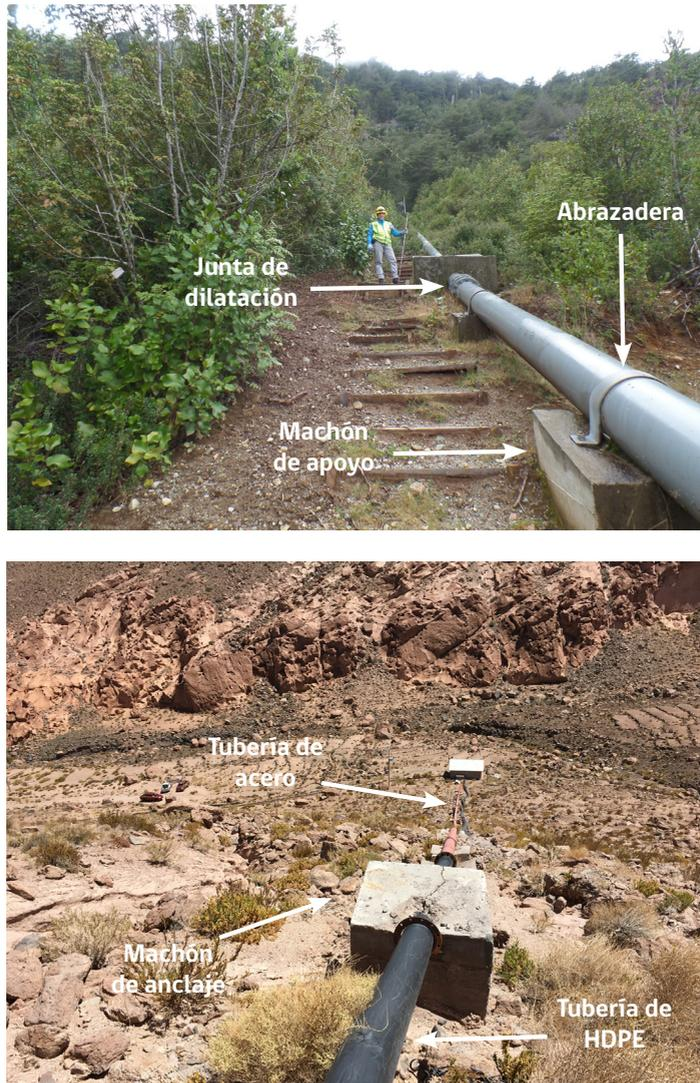
**Figura 7.36 - Elementos principales en la instalación de una tubería de presión.**
