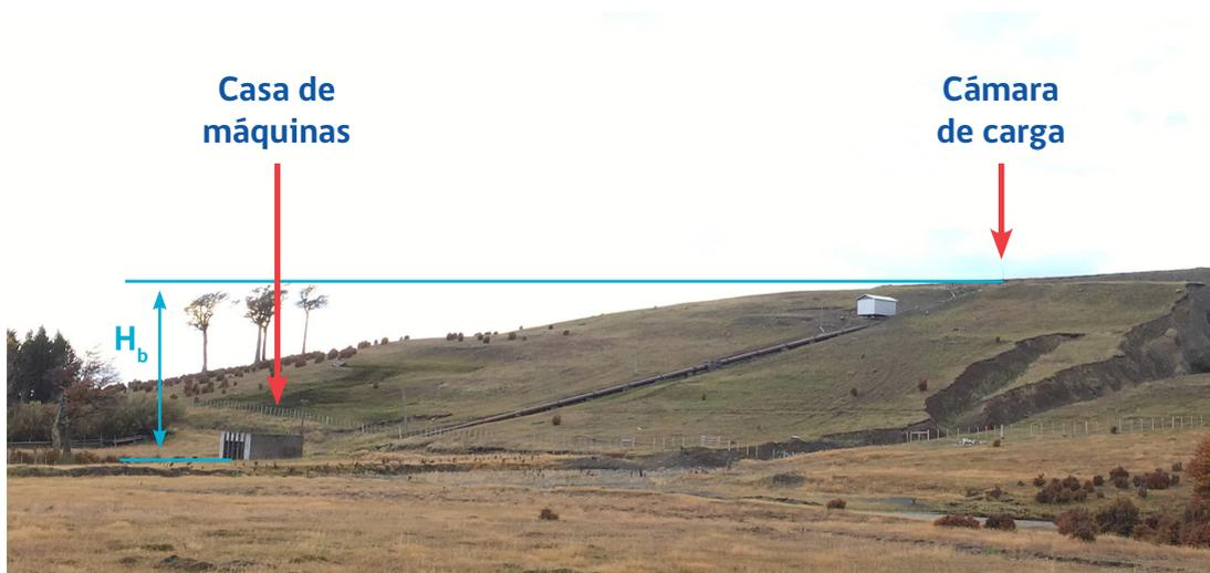
**Figura 7.21 - Altura bruta ( $H_b$ ) de un proyecto hidroeléctrico.**
