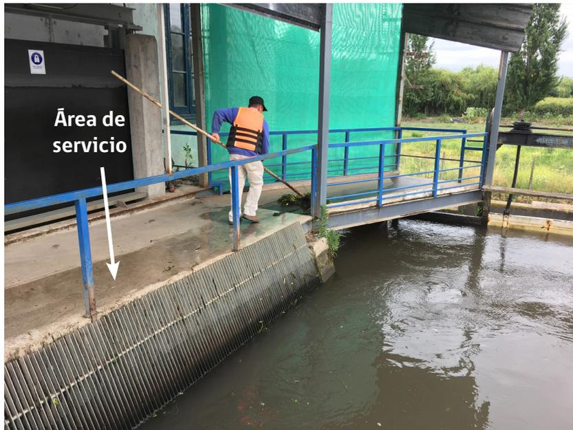
**Figura 7.35 - Diseño adecuado de una reja de limpieza en una cámara de carga.**
