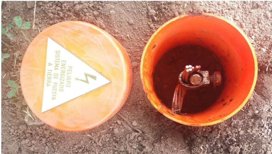
**Figura 7.51 - Muestra de zanjado y conexiones en malla de tierra.**
