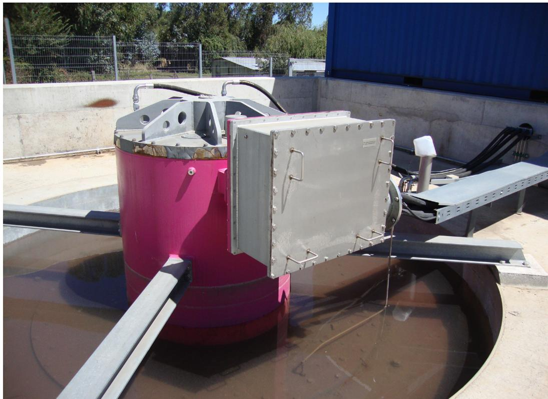
**Fig. 4.14 - Central hidro con Turbina Semi-Kaplan de 500 kW Central Munitque 1 Canal Biobio Negrete - Chile.**
