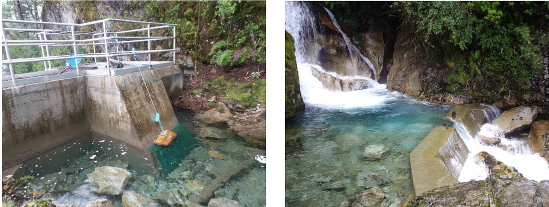
**Figura 7.8 - Bocatomas con barrera tipo azud (derecha) y captación lateral (izquierda).**
