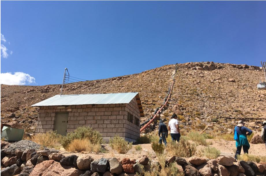
**Figura 7.39 - Tubería de presión en acero instalada en sobre el terreno en ladera con soportes equidistantes (sillas).**
