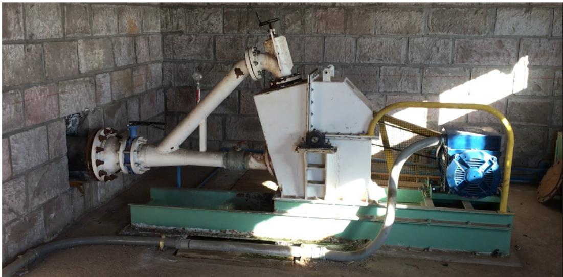
**Fig. 4.4 - Turbina Pelton de 12 kW en un sistema isla instalada en Talabre - Chile.**
