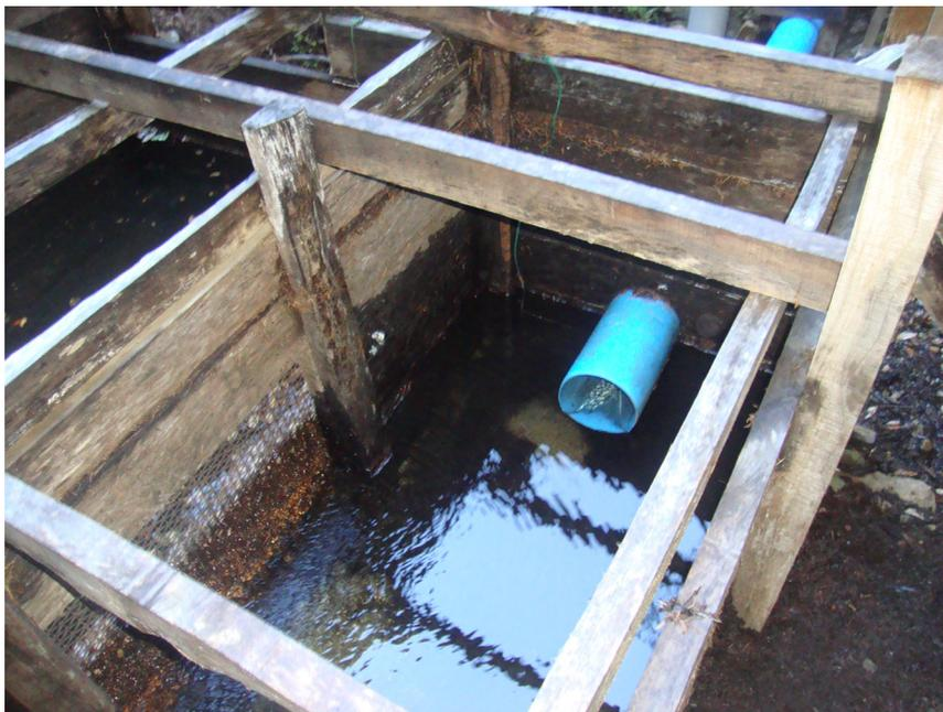
**Figura 7.34 - Cámara de carga para una microcentral que incorpora todos los elementos básicos.**
