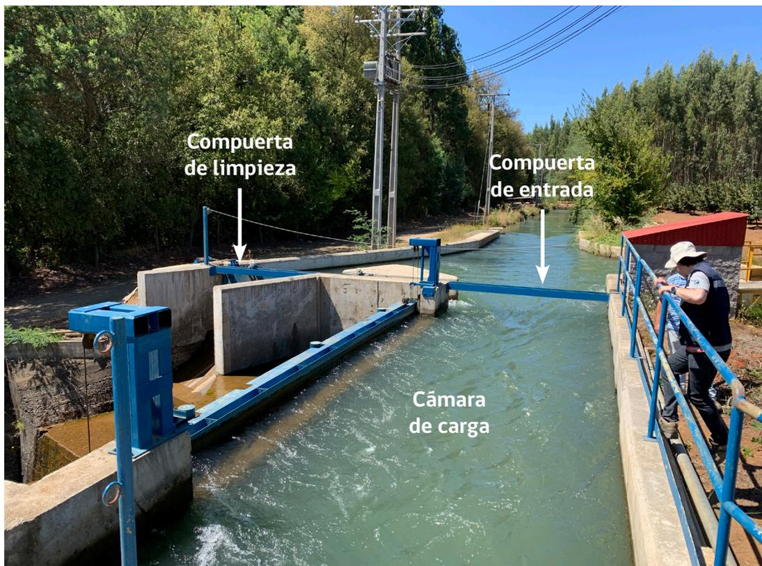
**Figura 7.6 – Componentes de una bocatoma en un canal de riego.**
