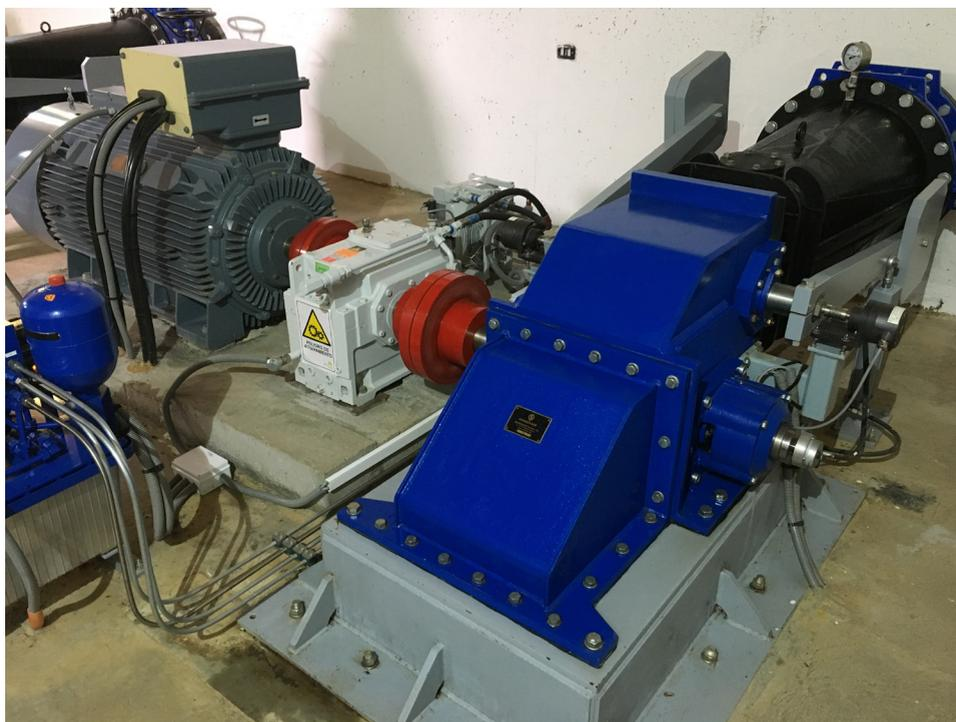
**Fig. 4.7 - Turbina flujo cruzado de 370kW instalada en Faja Maisan -Chile.**
