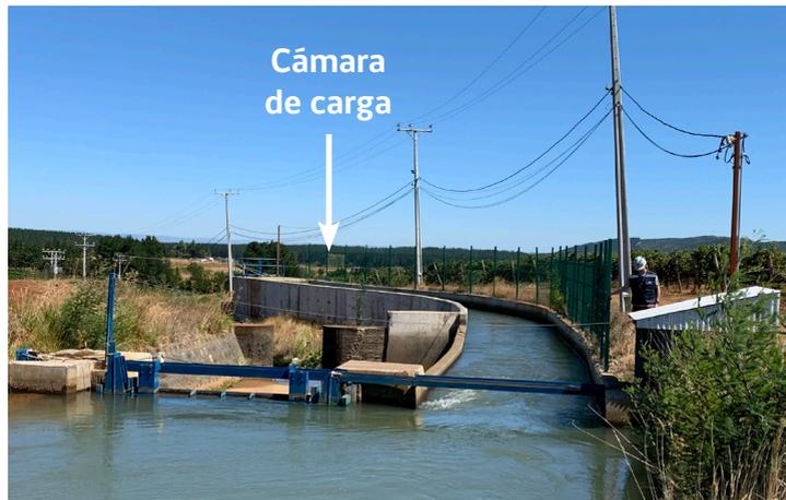
**Figura 7.29 - Esquema de una cámara de carga.**
