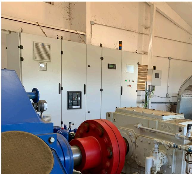
**Figura 7.45 - Ejemplo de tablero eléctrico de control, medición y control (Amperímetro y Voltímetro por fase; Frecuencímetro, Horómetro, Parada Manual, Medidor de Energía).**
