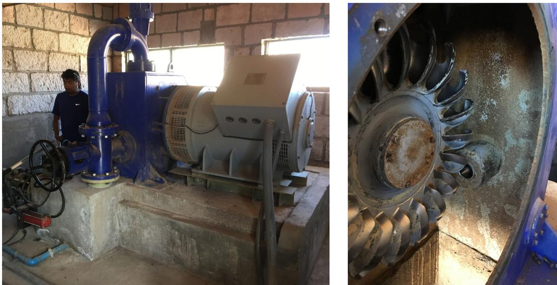
**Fig. 4.5 – Turbina Pelton operando con 100 l/s, altura bruta de 90 m, potencia de 100 kW, instalada en Socaire –Chile.**
