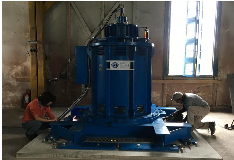
**Fig. 4.13 - Generador de Turbina Kaplan de 250 kW, Agrícola Dosal, Curicó - Chile.**
