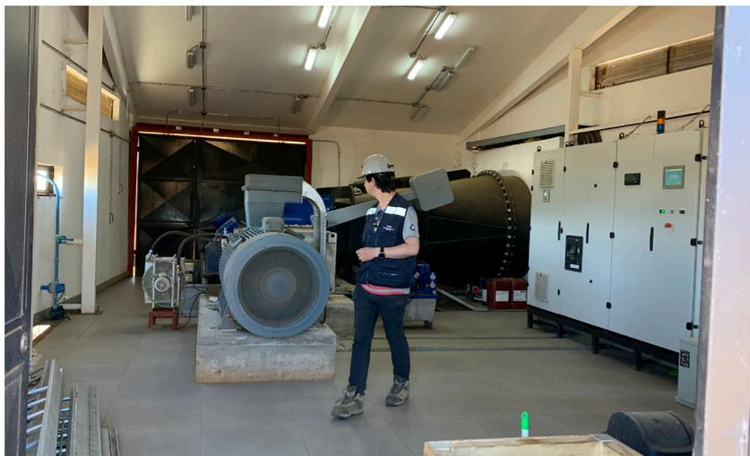
**Figura 7.50 - Ejemplo de Casa de Máquinas iluminada, ventilada, limpia y ordenada para permitir circulación y servicios sin riesgos para las personas.**
