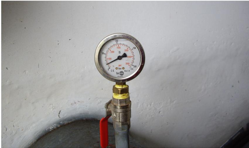
**Figura 7.42 - Localización de manómetro en Tubería de Presión.**
