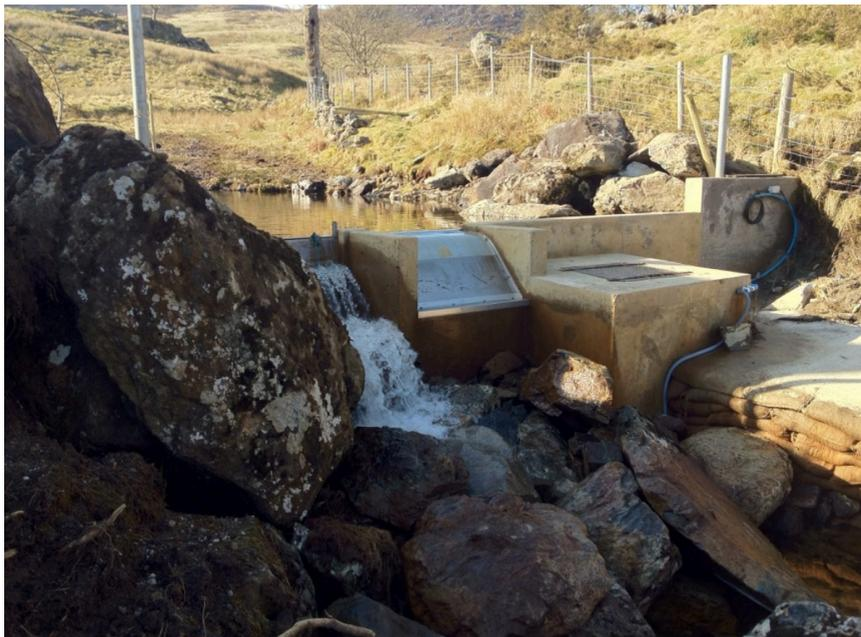
**Figura 7.12 - Instalación de captación de agua para microcentrales hidroeléctricas.**
