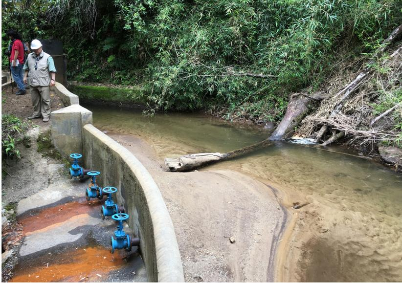
**Figura 7.3 - Depósitos en un segmento curvo de un cauce.**
