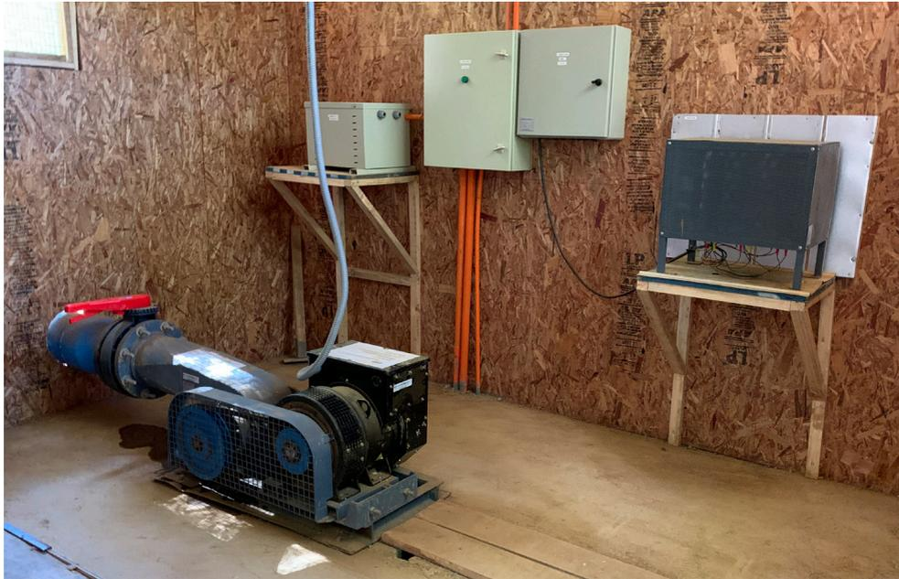
**Figura 7.48 – Instalación tipo de control electrónico de carga con carga lastre (o balasto) de disipación al aire, instalada en el muro.**
