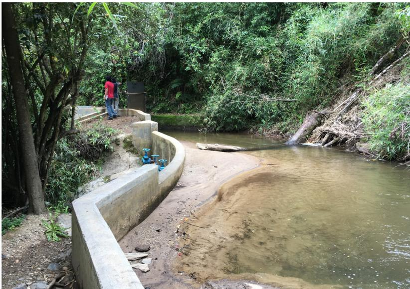
**Figura 7.2 - Depósito en segmento curvo del canal.**
