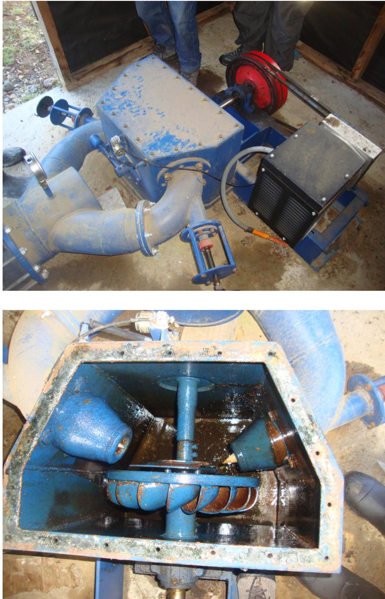
**Fig. 4.6 - Turbina Turgo de 4 kW emplazada en Mañihuales -Chile.**
