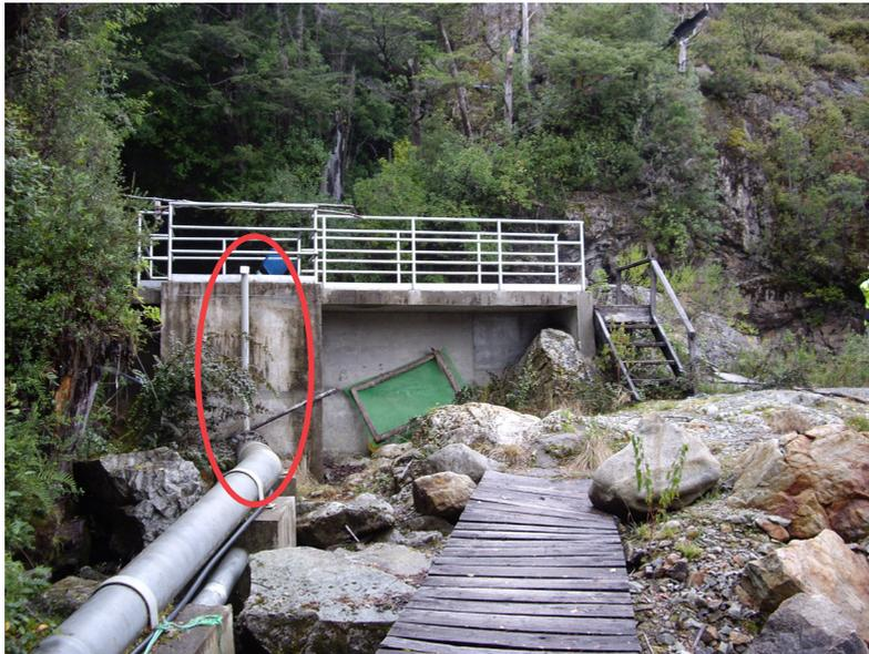
**Figura 7.27 - Ejemplo de tubería de venteo al inicio de una tubería de salida de una cámara de carga.**
