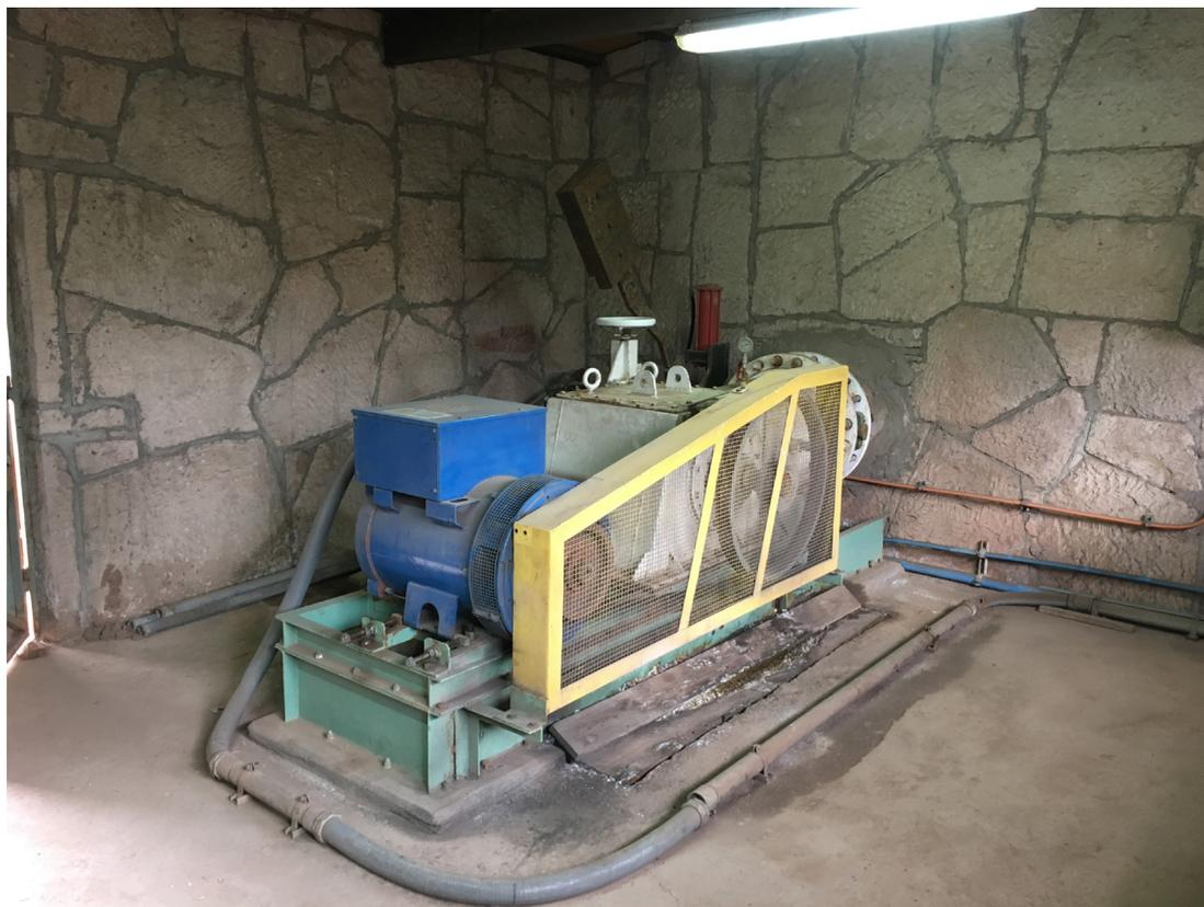
**Fig. 4.8 - Turbina de flujo cruzado el caudal es de 380 l/s y posee una altura bruta de 18m, con potencia de 37,6 kW, instalada en Río Grande -Chile.**
