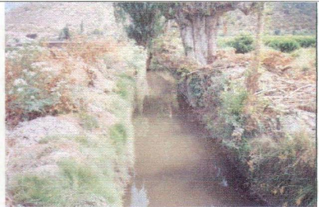
**Foto 6. Sección.** Tramo irregular del canal donde existe un altillo y vegetación en la sección del canal.
