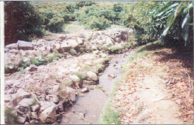
**Foto 12. Descarga a Canal Del Bajo.** Tramo que necesita revestimiento para evitar erosión del terreno.
