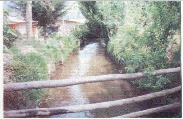
**Foto 8. Sección.** Tramo irregular del canal y curva cerrada que limita la velocidad de flujo. Además existe abundante vegetación en los bordes.
