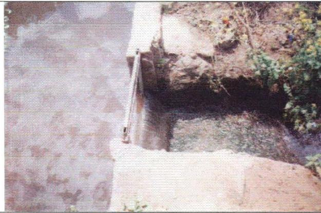
**Foto 11. Compuerta Descarga Canal Del Medio a Canal del Bajo.** Se necesita una estructura de descarga para evitar erosión en terreno.
