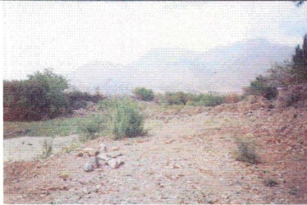
**Foto 7. Cruce Estero Chacarillas.** En las crecidas del estero se corta el canal y existen habituales filtraciones. En este lugar se construirá un sifón.
