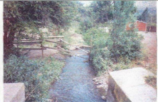
**Foto 10. Sección.** Tramo irregular del canal. Se necesita revestimiento.
