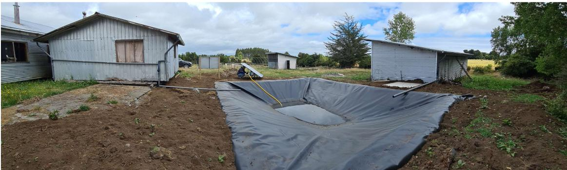
Fotografía 24. Sistema de acumulación de aguas lluvias revestido con geomembrana.
