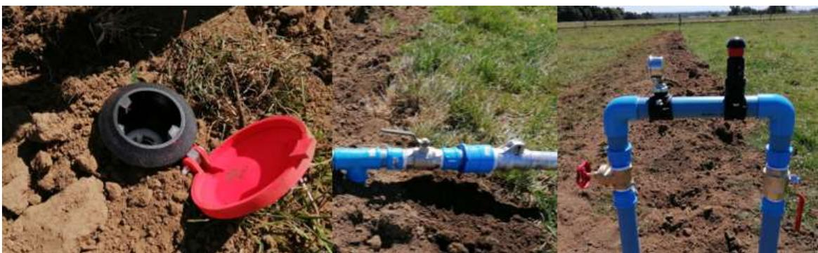
Fotografía 22. Hidrantes y nodo de control para sistema de riego por aspersión.
