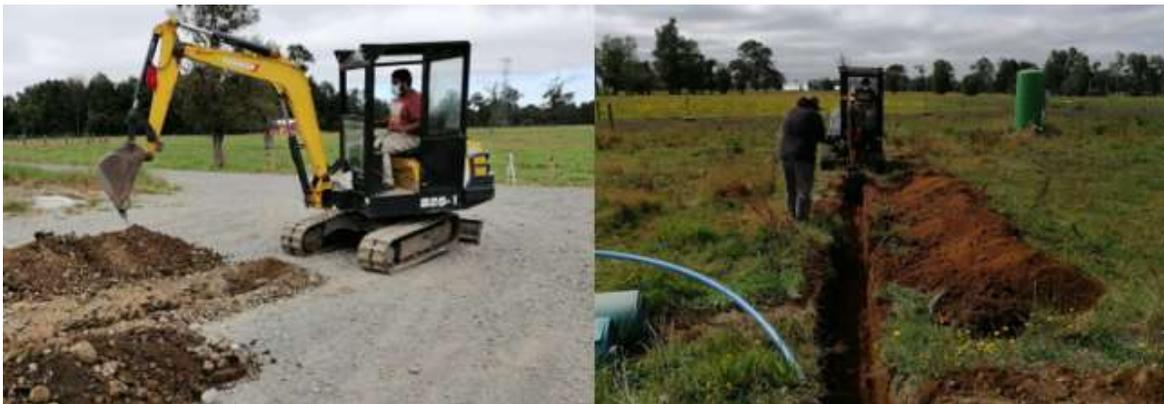
Fotografía 21. Instalación de tubería matriz.
