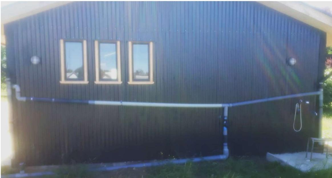
Fotografía 15. Sistema de conducción de aguas lluvias.
