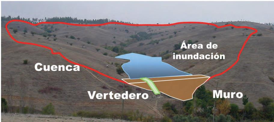
**Figura 8.** Embalses y sus componentes principales.
