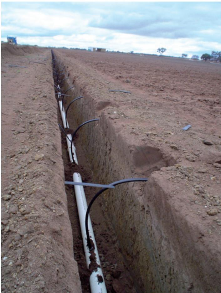
Con los sistemas de goteo subterráneo se reducen las posibilidades de contacto del efluente con las personas ya que el agua es aplicada bajo la superficie del suelo.
