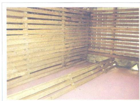
Foto 12.6 Entrada de aire lateral a la troja a través de ductos triangulares.
