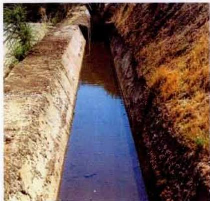
*Revestimiento de canal con arcilla en fondo y paredes del canal.*
