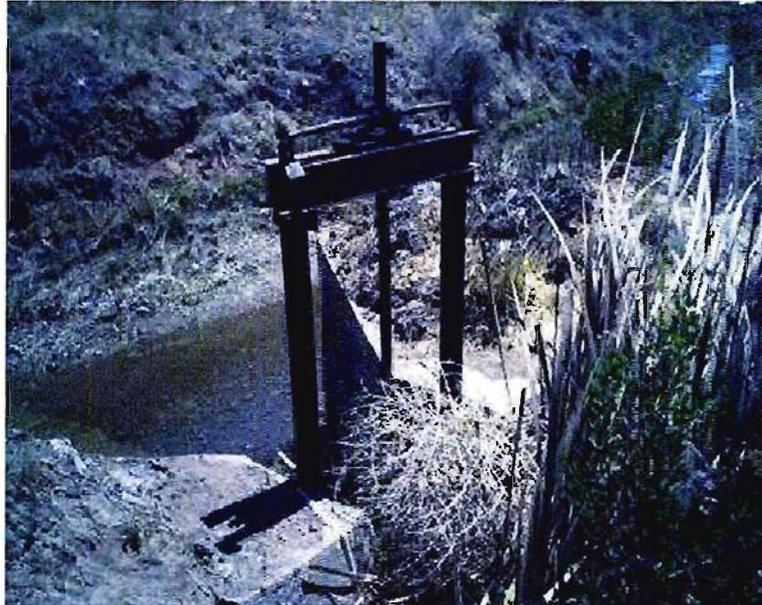
**Fotografía 2-6 Compuerta de acero en mal estado**
