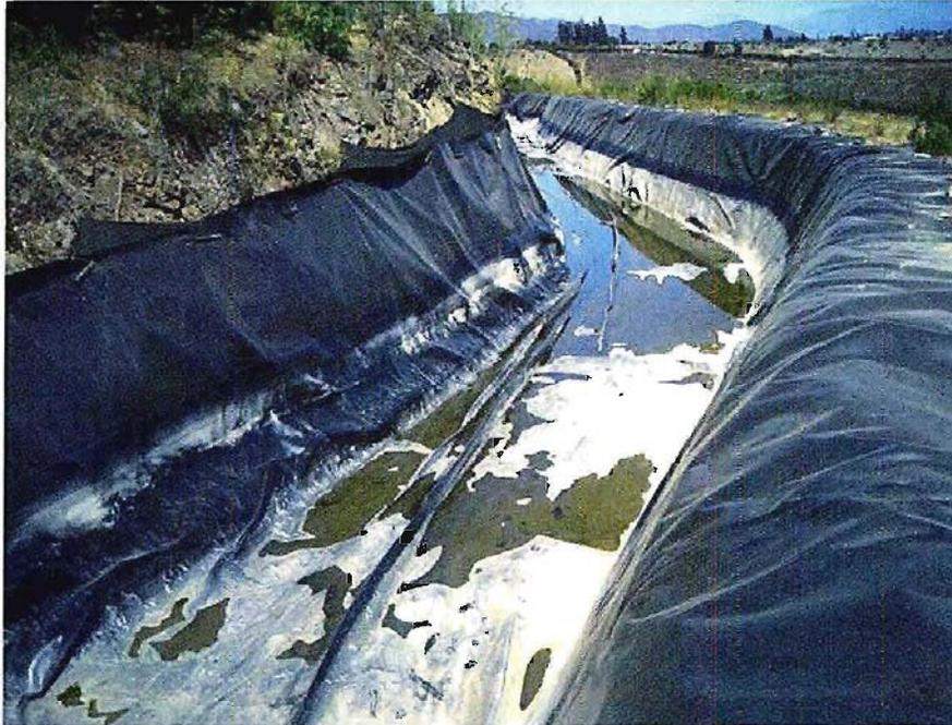
Debido a las condiciones diversas de mantención a lo largo del canal se adoptaron valores diferentes para los revestimientos, dentro del rango definido en la Tabla 2-2, así como también se detectó un tramo con revestimiento en geomembrana. El detalle completo de los coeficientes de rugosidad adoptados en el canal Villalón se presenta en la Tabla 2-3.
