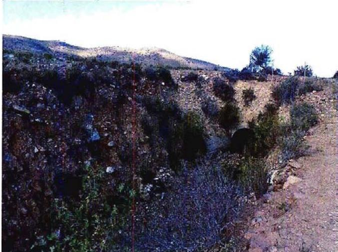
Estos desprendimientos pueden ser manejados mediante mantenciones periódicas anuales y en el caso de algún evento sísmico o lluvias de gran intensidad, se sugiere verificar el correcto funcionamiento de las obras mediante una mantención adicional en los días próximos al suceso.
