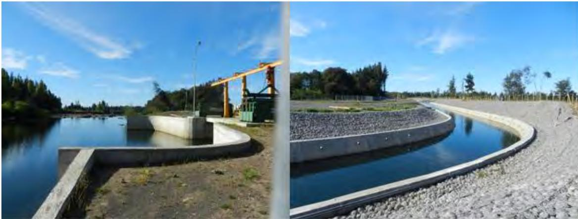
Fotografía 17. Bocatoma de Eléctrica Puntilla.
