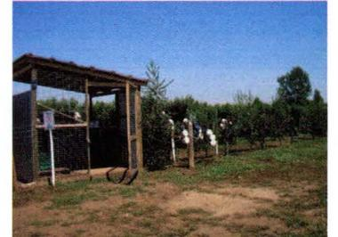
Piso de concreto, mesones de madera cubiertos de plástico, malla acma y techo de zinc
