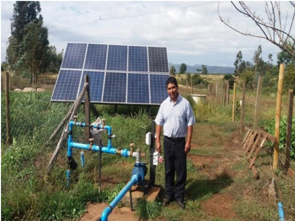
Fotografía 7. Cabezal sin protección.
