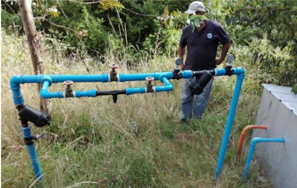
Fotografía 17. Instalación de fertirriego con Venturi.
