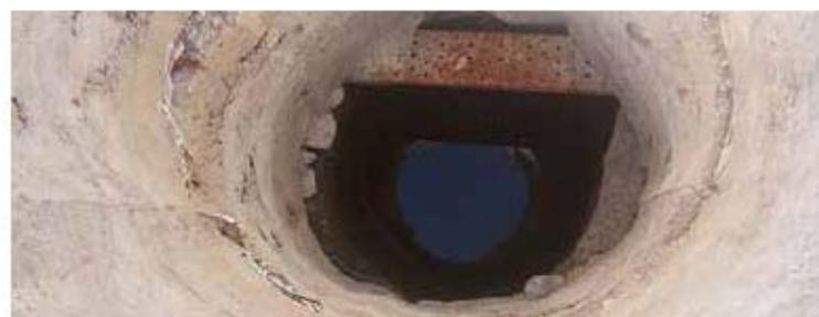
Imagen 25: Pozo de uso agrícola, revestido de concreto
