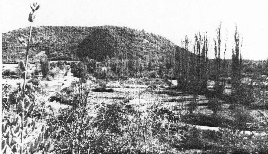
FOTO N° 37. Sitio de presa El Peñasco. Vista del lado izquierdo desde el derecho. Se destaca el cerrillo constituido por el núcleo basáltico y sedimentos aterrazados que lo rodean por su lado poniente. Hacia el lado derecho de la foto se abre el valle central.
