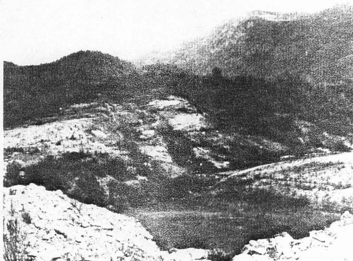
FOTO N° 27. Vista de la parte ya colocada del núcleo. Al fondo se divisa la zona del empotramiento izquierdo desprovisto de la sobrecarga que sobre él se apoyaba.
