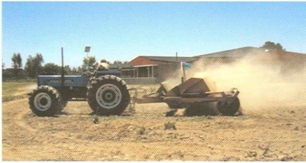
**Foto 12.** Labor de nivelación de un terreno con una “trailla”, equipo que permite una máxima efectividad en la labor.
