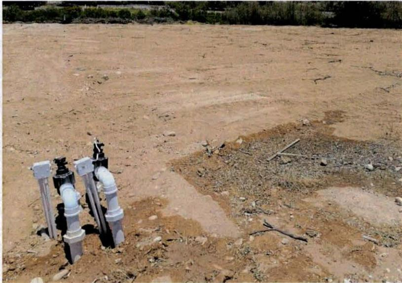
Fotografía 4-13 Válvulas de descole para limpieza de las submatrices.
