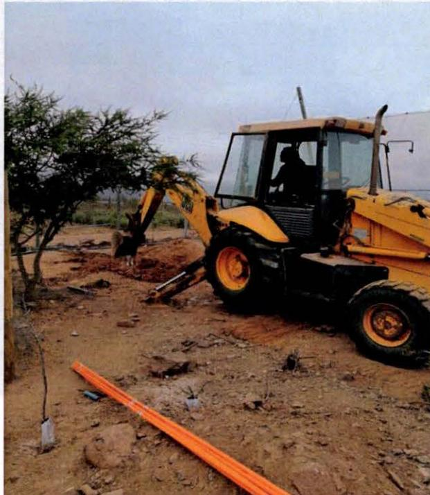
Fotografía 4-4 Cableado a nodos de control para su electrificación
