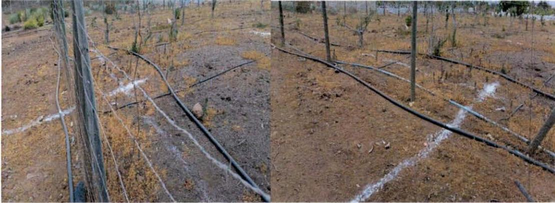
Al día siguiente, 3 de noviembre, se inician las excavaciones en los puntos del trazado ya replanteado el día anterior y de forma paralela, se cablea las tuberías hasta cada nodo de control para su posterior electrificación y se unen las tuberías hidráulicas correspondientes a las matrices y secundarios a medida que avanza la excavación.
