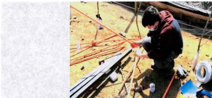
Fotografía 4-5 Acoplamiento de tuberías matrices y secundarias.
