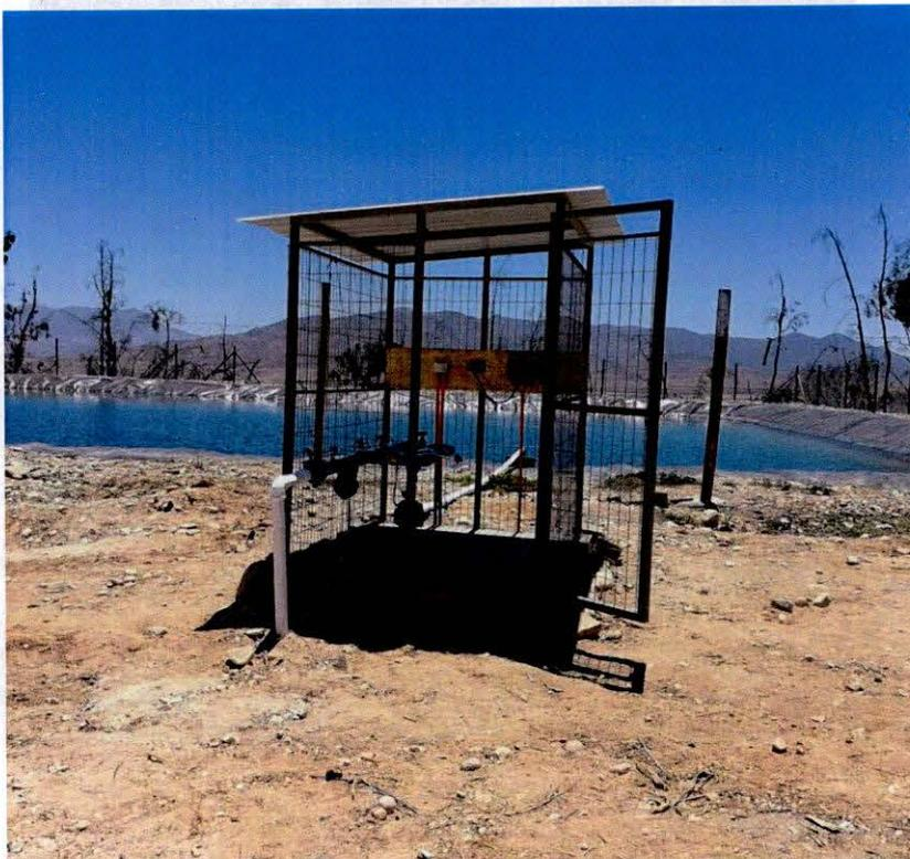
Fotografía 4-18 Bomba conectada a la succión e impulsión.
