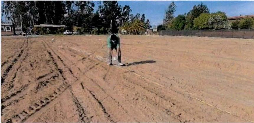
Al siguiente día, 10 de noviembre, se inician las excavaciones en los puntos del trazado ya replanteado el día anterior y de forma paralela, se cablea las tuberías hasta cada nodo de control para su posterior electrificación y se unen las tuberías hidráulicas correspondientes a las matrices y secundarios a medida que avanza la excavación.
