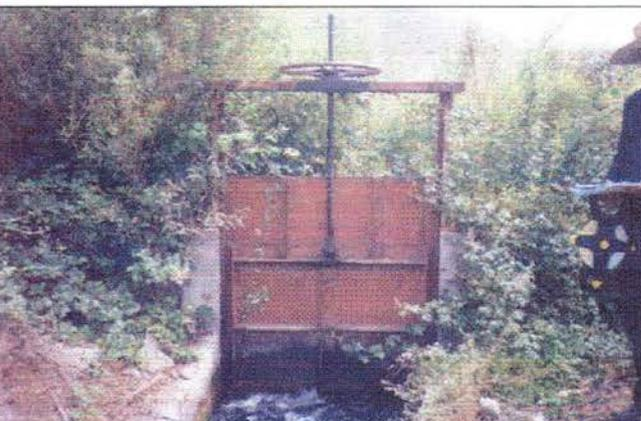
**Foto 10. Compuerta de Regulación.** Detalle de la compuerta vista hacia aguas arriba del canal.
