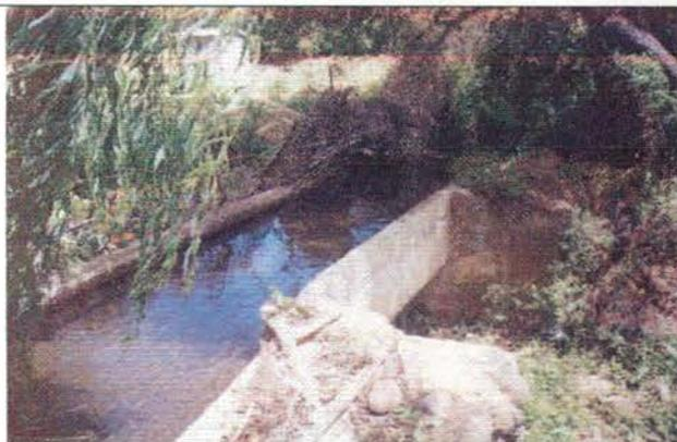
**Foto 19. Canoa.** Estructura de hormigón en paso del canal sobre quebrada Los Perales.
