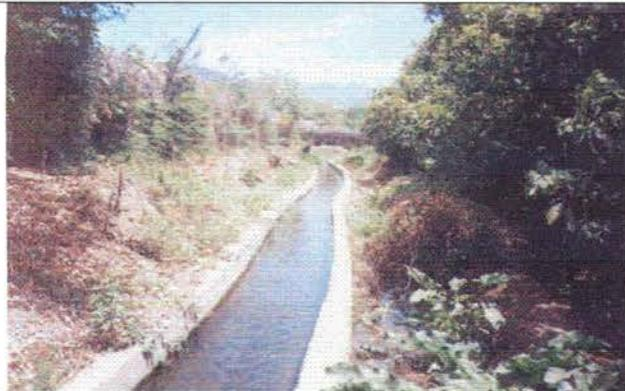
**Foto 15. Tramo 2 Revestido.** Detalle de la sección del canal.
