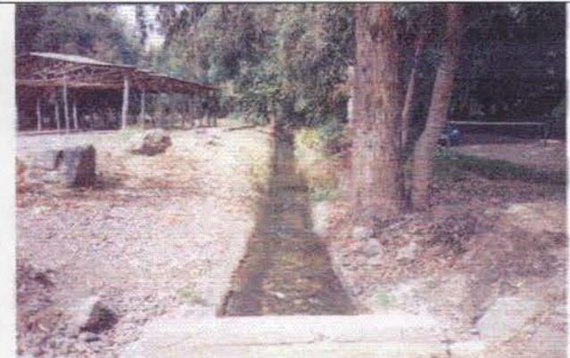
**Foto 6. Canal Conductor de las Aguas del Dren Cabildo.** Tramo en Parque Municipal, se aprecia deterioro en el revestimiento.
