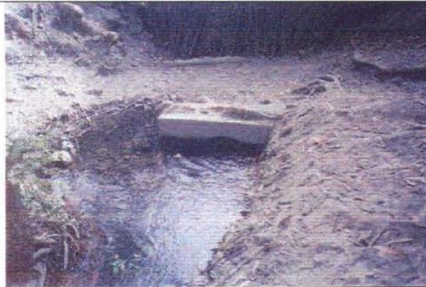
**Foto 3. Salida a Superficie de Dren Cabildo.** Las aguas escurren por un canal revestido por aproximadamente 2 000 m hasta su unión con el canal Montegrande.
