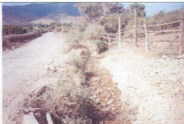
**Foto 24. Último Punto del Canal.** Sección sin revestimiento en cruce con camino La Patagua.
