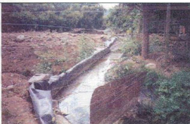
**Foto 22. Canoa.** Canoa provisoria de madera revestida en plástico para el paso de las aguas del canal sobre la quebrada Nahuel.
