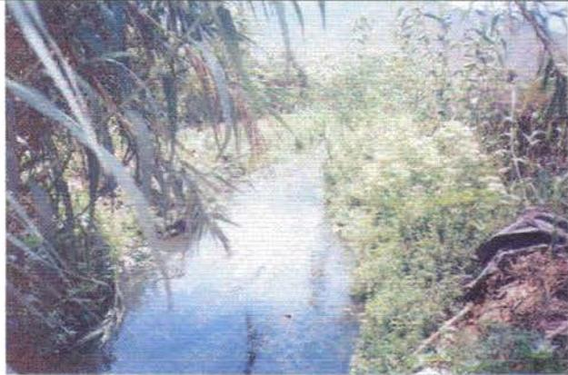
**Foto 13. Sección.** Tramo del canal sin revestir y con problemas de enmalezamiento y vegetación acuática.
