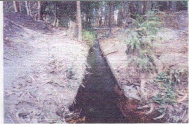
**Foto 4. Canal Conductor de las Aguas del Dren Cabildo.** Se observa en mal estado debido a daños provocados por raíces de árboles.
