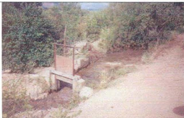
**Foto 23. Entrega a Tranque La Viña.** Punto de entrega de las aguas del canal Montegrando al tranque La Higuera para posteriormente ser entregadas al canal La Palma.
