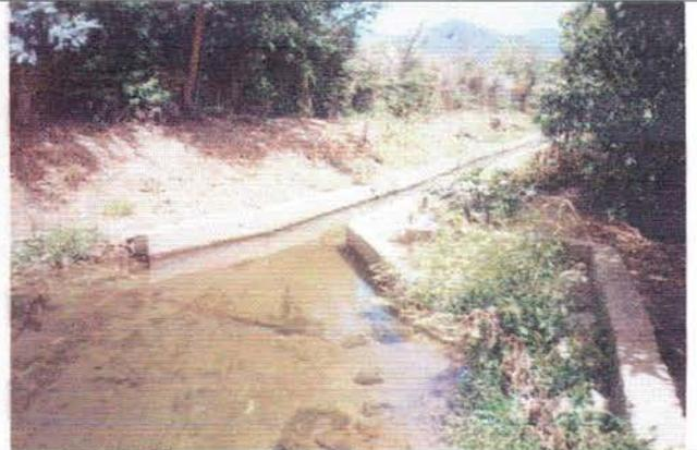
**Foto 14. Tramo 2 Revestido.** Inicio revestimiento en hormigón por 1.750 m.
