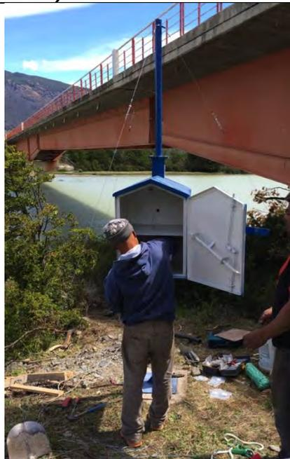
Fotografía N°32. Instalación caseta estación Río Leones (Fuente: DesHielos, nov.2014).
