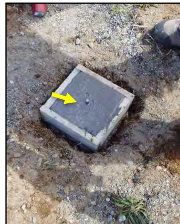
**Fotografía N°10. Punto calado de cota (Fuente: DesHielos, nov.2014).**
