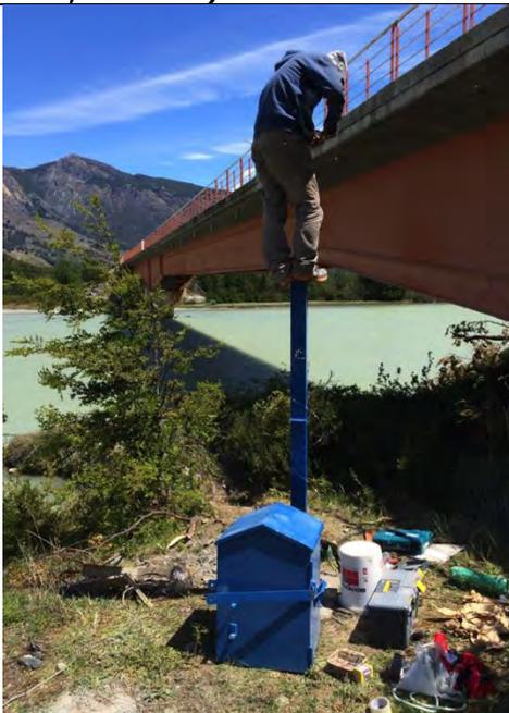
Fotografía N°31. Instalación de tirantes en mástil estación Río Leones (Fuente: DesHielos, nov.2014).
