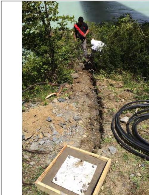
Fotografía N°29. Base de mástil y zanja para tubo que cubre sensor en estación Río Leones (Fuente: DesHielos, nov.2014).
