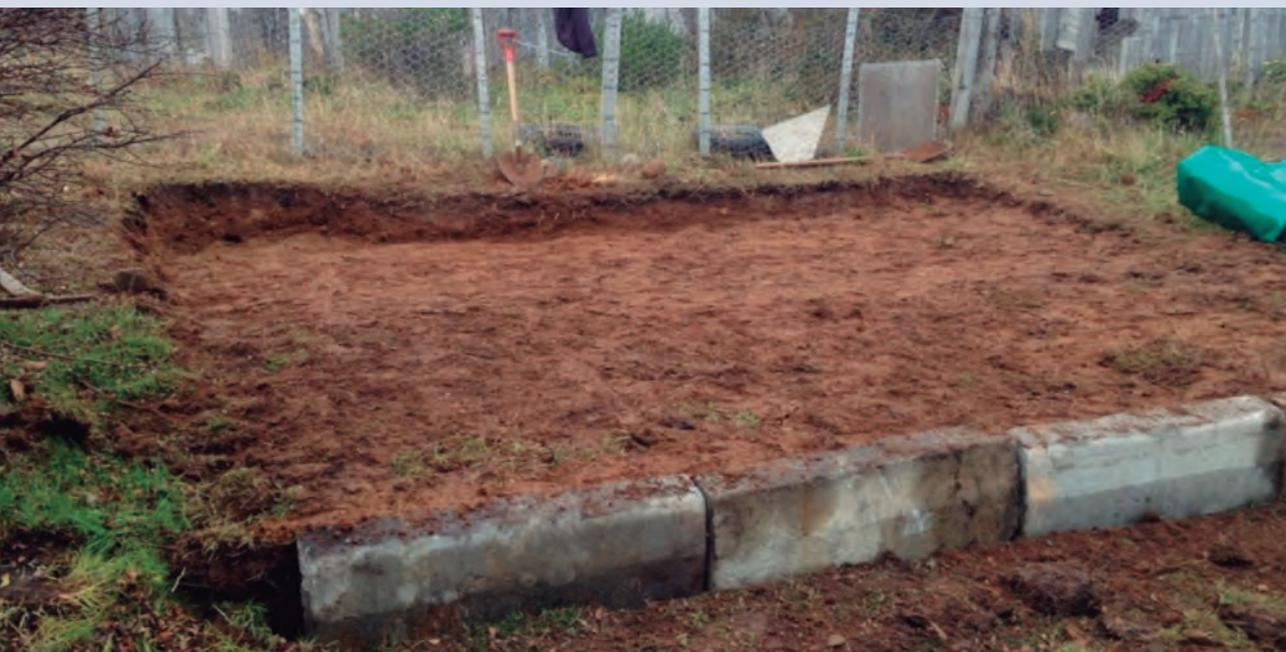
**Figura 10:** Nivelación de terreno para ubicación de cisterna flexible.
