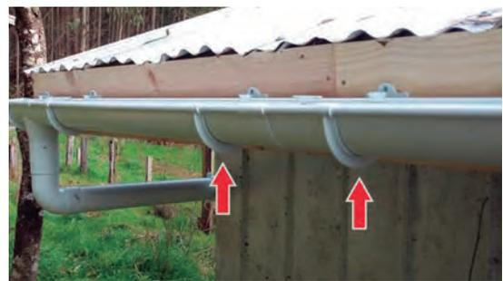
**Figura 4:** Ganchos de sujeción ubicados a 15 cm desde la unión de dos canaletas para entregar mayor resistencia.
