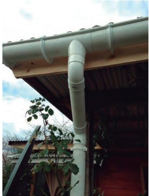
**Figura 5:** Ganchos de sujeción ubicados al costado de la bajada de agua.
