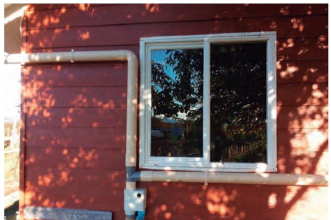
**Figura 7:** Modelos de conexión de dos aguas a través de Tee sanitaria de 75 mm.
