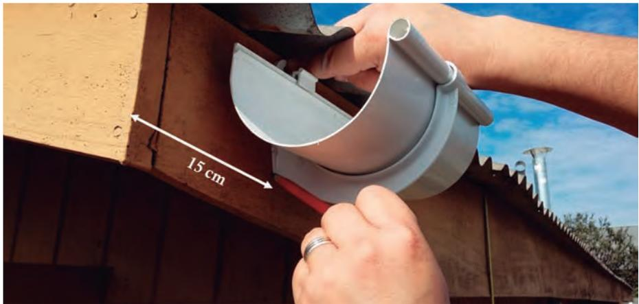
**Figura 1:** Ubicación del primer gancho de sujeción para dar inclinación a la canaleta.
