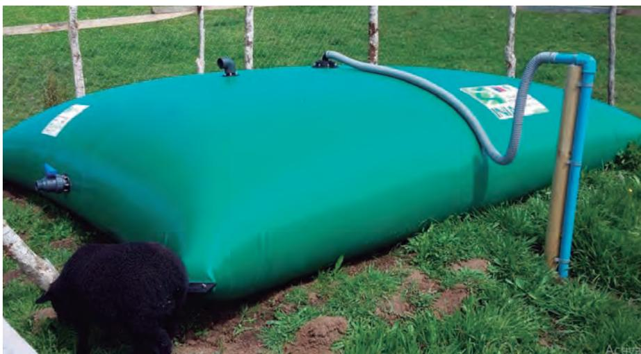
**Figura 11:** Cisterna flexible a máxima capacidad con sistema de colecta de aguas lluvias.
