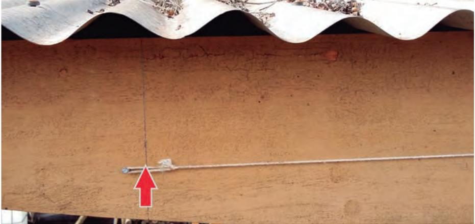
**Figura 2:** Ubicación de lienza para nivelación de canaleta y ganchos de sujeción.
