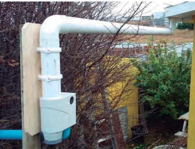
**Figura 8:** Filtro de polietileno para retener impurezas de mayor tamaño, como hojas e insectos.
