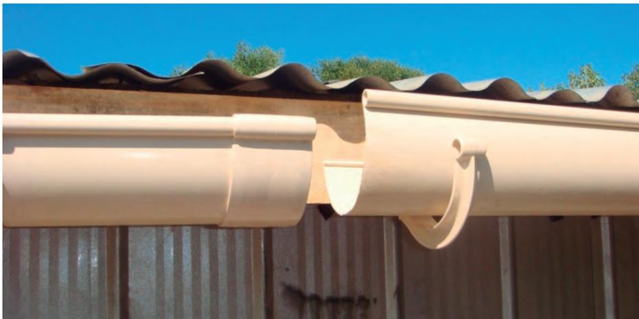
**Figura 6:** Unión de canaletas en altura para facilitar montaje.
