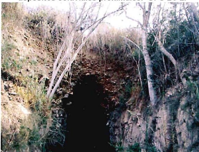
**Fotografía 4-81.- Detalle de la pared izquierda del portal de entrada del túnel, ilustrando el aspecto de los depósitos en los que se excavó el portal. GPS LC 5**
