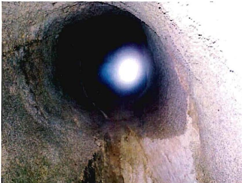
**Fotografía 4-31.- Detalle de la tercera “lumbrera” excavada en roca intrusiva como las anteriores. En borde inferior de la fotografía se observa la clave del túnel. GPS TB 78.**
