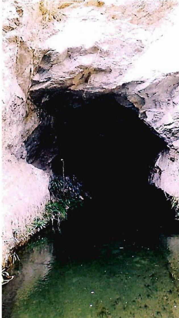
Fotografía 4-55.- Detalle de la clave del túnel Quilacán 3 mostrando trazas de la excavación del túnel, indicando además que se trata de una roca dura. GPS Q3 51.
