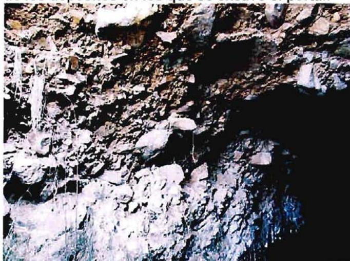
Fotografía 4-82.- Detalle del túnel a los 23 m, mostrando un gran bloque métrico colgando desde la clave. GPS LC 9
