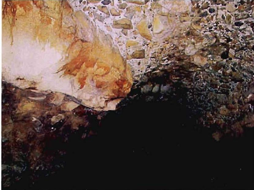
Fotografía 4-83.- Aspecto del túnel a los 95-98 m con un gran bloque métrico (> 2m) que condiciona la forma de la clave en esa parte del túnel. GHPS LC 17
