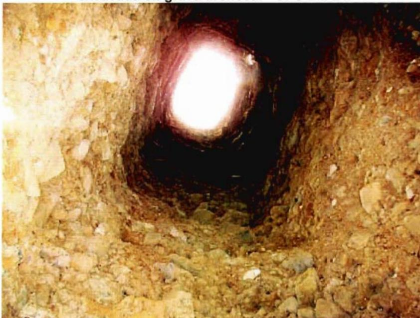
Fotografía 4-77.- Detalle de la clave del túnel entre los 12 y 15 m, mostrando un bloque colgante de unos 0,8 m de eje mayor. GPS EM 9.
