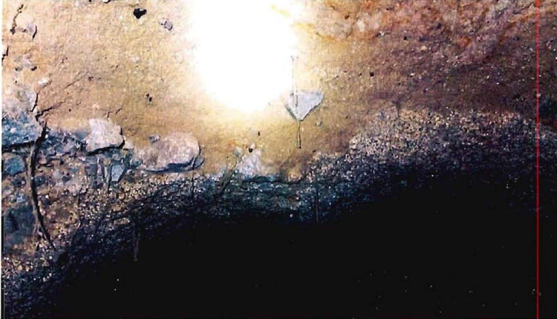
Fotografía 4-25.- sector de la clave del túnel en el primer tramo, a los 72 m aproximadamente. Se aprecia la presencia de niveles de gravas y arenas litificadas asignadas a los depósitos coluviales que además contienen clastos redondeados de granitoides productos de la meteorización bolar. GPS P 40.
