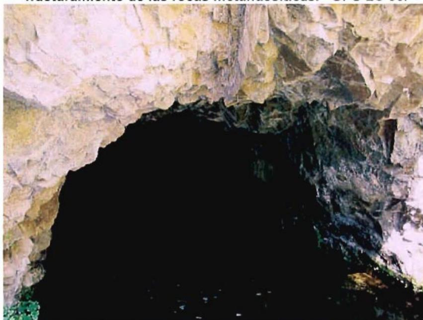
Fotografía 4-92.- Vista del sector superior del portal de salida, mostrando fracturas y el recubrimiento del portal. GPS LC 28.
