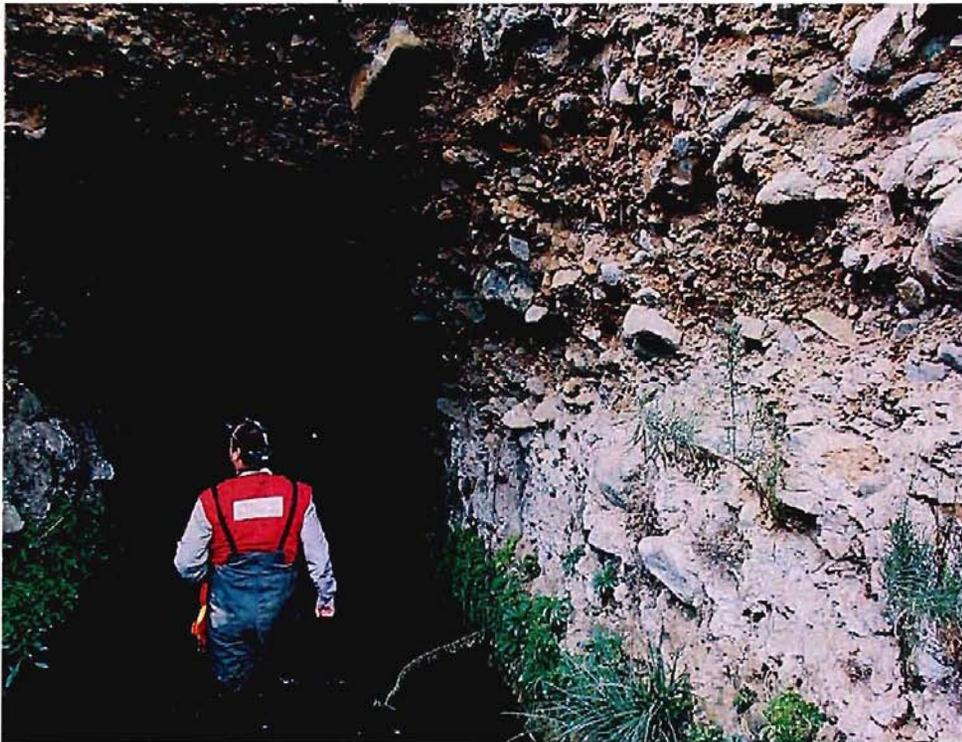
Fotografía 4-73.- Aspecto del interior del túnel hacia los 100 m desde el portal de entrada. Se observa que está excavado en gravas arenosas. GPS EM 16
