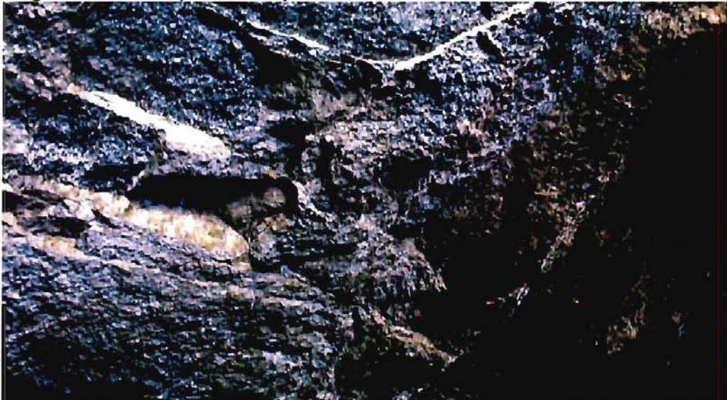
Fotografía 4-45.- Parte media del túnel mostrando marcas del caudal máximo en la zona de la clave del túnel, indicando el funcionamiento en presión de parte del túnel. GPS Q1 10.
