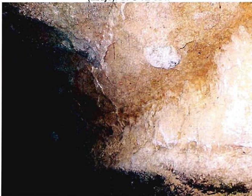
Fotografía 4-28.- Detalle en la pared izquierda del túnel a los 595 m, mostrando el contacto roca meteorizada (arriba) y más fresca (abajo). En la zona de contacto y hacia arriba (zona más meteorizada) sobresalen bloques de roca menos meteorizados (parte derecha de la imagen), lo que sugiere una mayor cercanía a la superficie o a los depósitos coluviales. GPS P 55.
