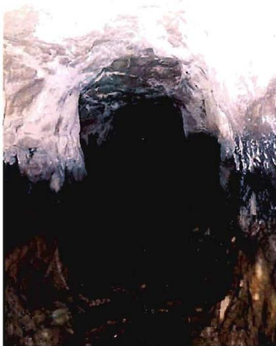
Fotografía 4-12.- Otra sección del túnel a los 42 m en donde se observa el piso limpio, a excepción de unos bloques desprendidos desde la clave. GPS TB 104.
