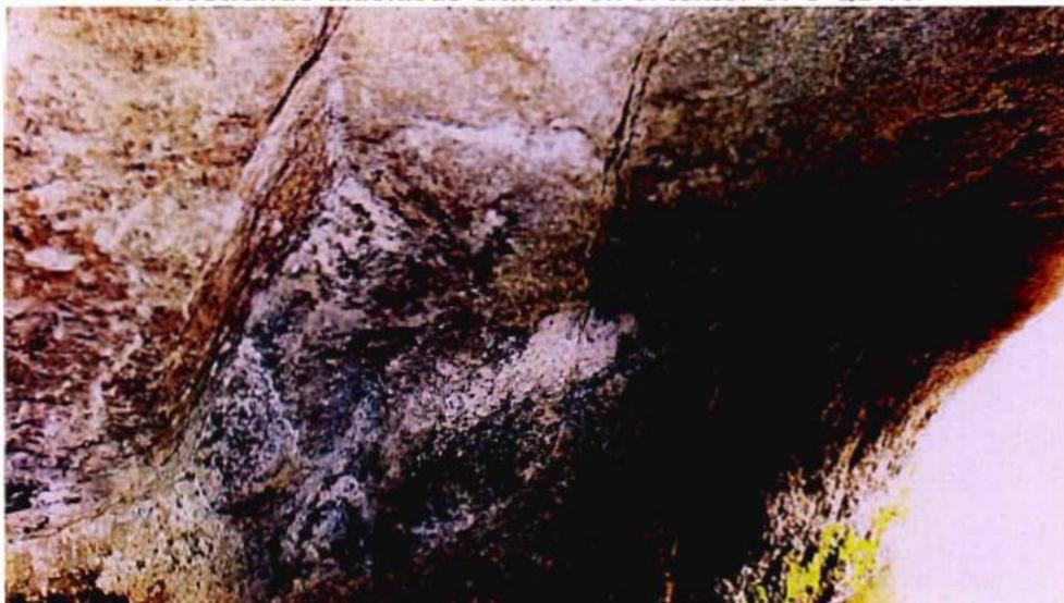
Fotografía 4-50.- Vista general del interior del túnel mostrando las marcas de nivel de caudal máximo, confirmando que este túnel suele funcionar en presión. GPS Q2 10.
