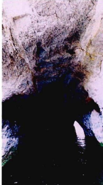
**Fotografía 4-49.- Detalle en la pared izquierda del túnel cerca del portal de salida, mostrando diaclasas citadas en el texto. GPS Q2 18.**
