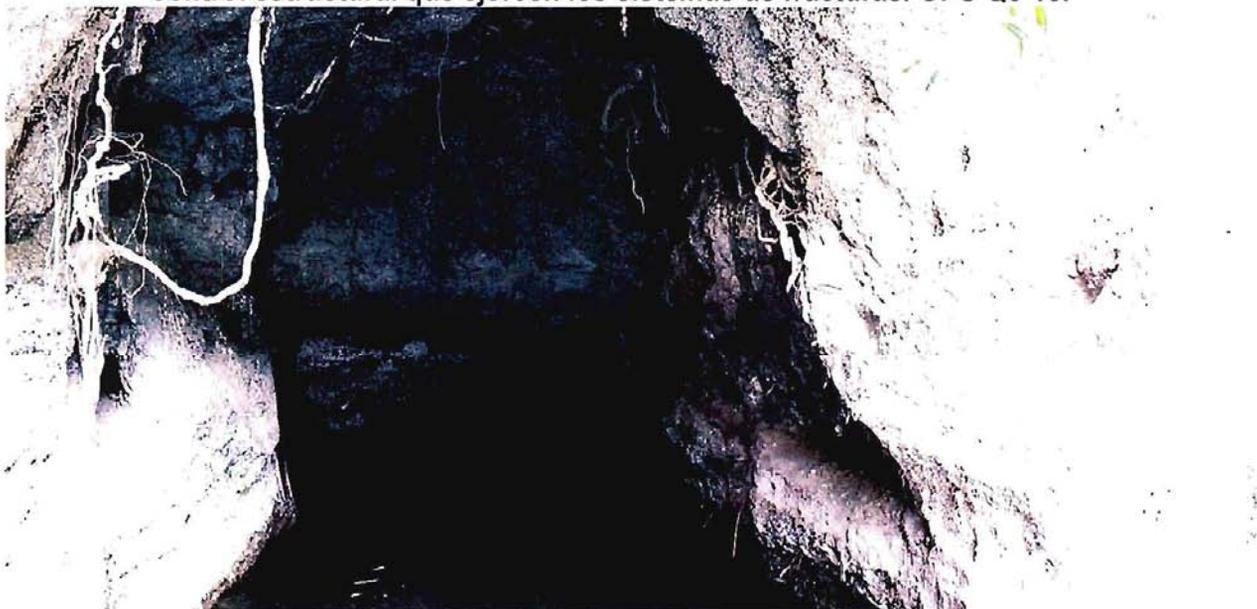
Fotografía 4-54.- Panorama del portal de salida del túnel Quilacán 3, que presenta algunos de los principales sistemas estructurales y el grado de meteorización de la roca intrusiva.
