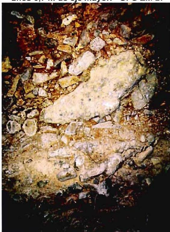
**Fotografía 4-79.- Vista de detalle de la clave del túnel entre los metros 190 a 195 (pasado la “lumbreira”) en la cual se aprecia una serie de bloques colgados de 0,3 a 0,4 m de eje mayor. GPS EM 38**
