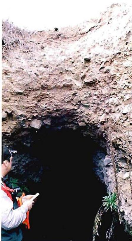
Fotografía 4-70.- Detalle del interior del túnel en los primeros metros, mostrando sobreexcavación. GPS Q5 13.
