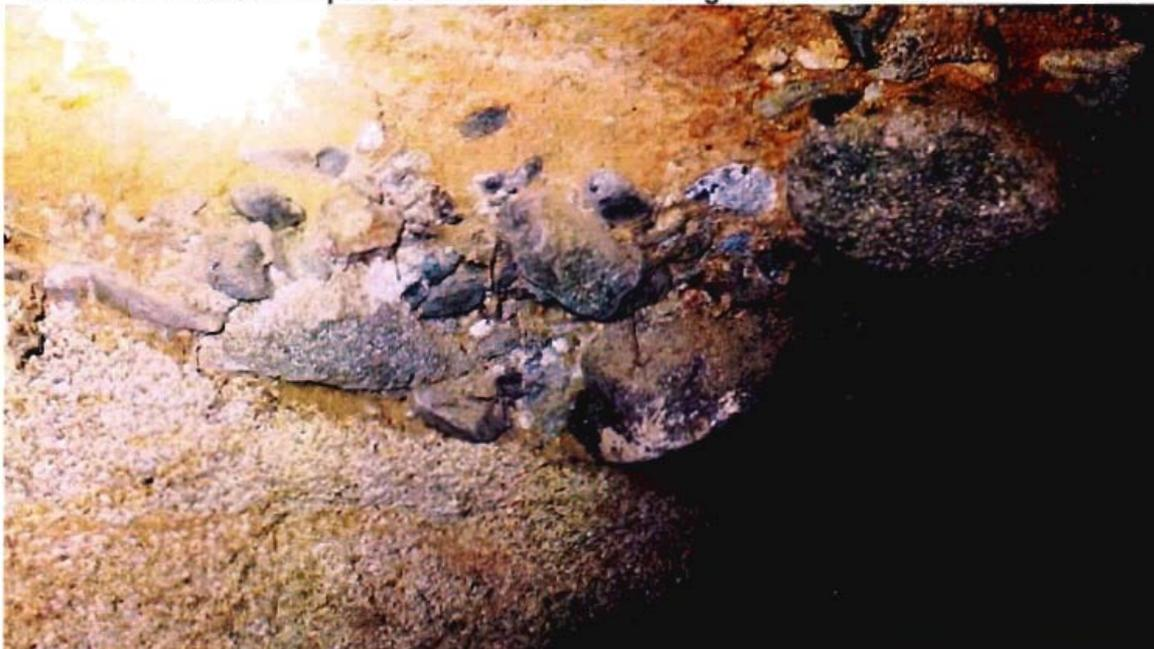
Fotografía 4-24.- Detalle de la clave del túnel a unos 20 m del portal de entrada mostrando como el nivel de suelo coluvial desaparece por sobre la clave. GPS P 16.
