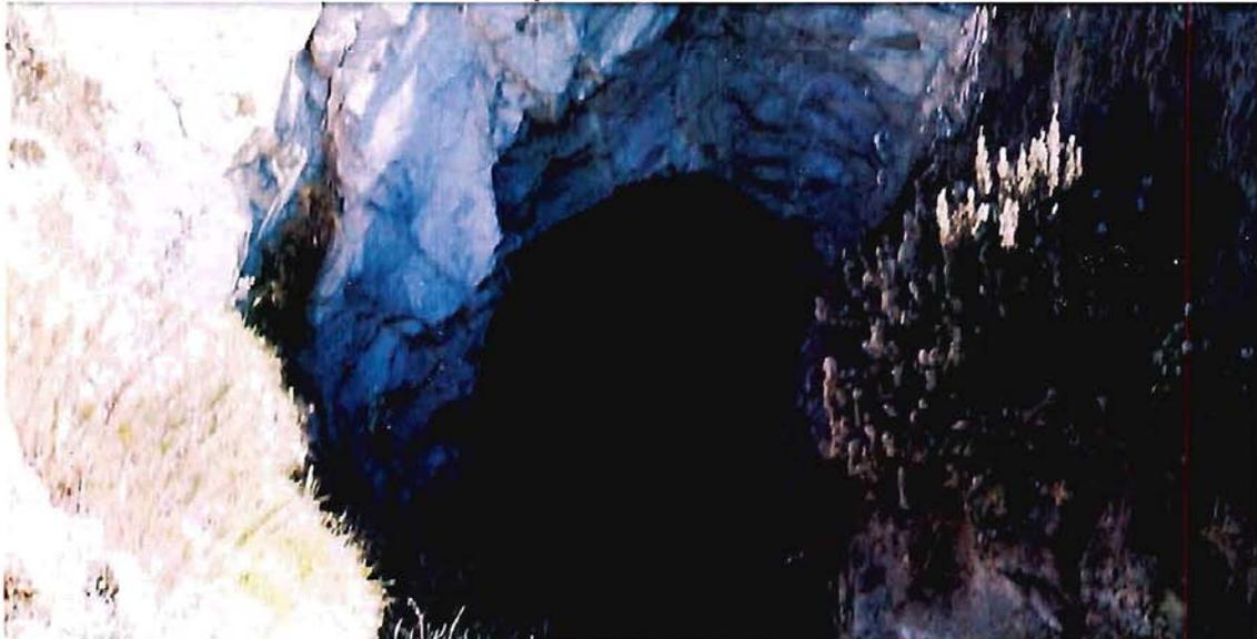
**Fotografía 4-63.- Aspecto de la parte final del Túnel Quilacán 4, mostrando sobreexcavación controlada por fracturas (ver texto). GPS Q4 30.**
