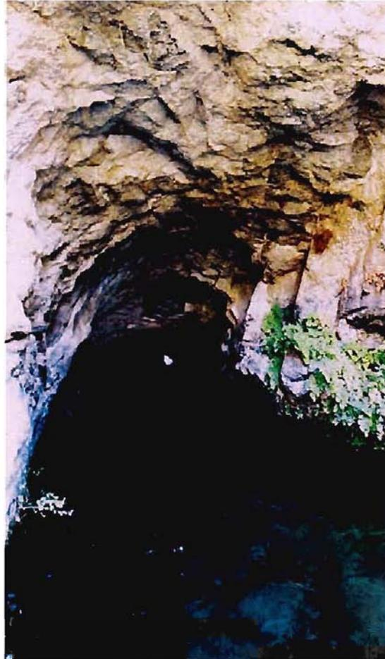
Fotografía 4-43.- Vista de detalle del costado derecho del portal de salida del túnel Quilacán 1 mostrando un sistema de fracturas transversales al eje del túnel. GPS Q1 11.
