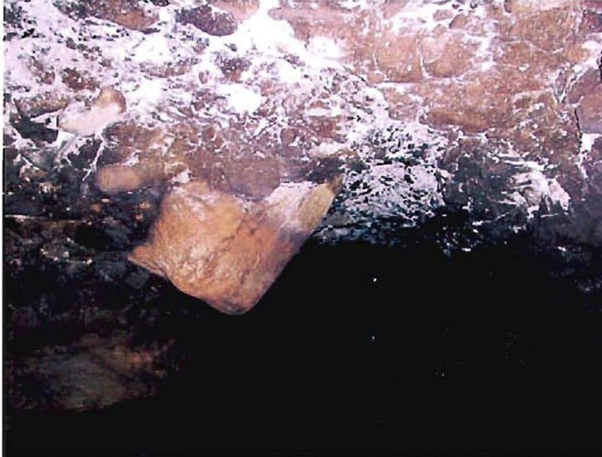
Fotografía 4-87.- Vista de la “Lumbrera” excavada en depósito coluviales. En el lado inferior izquierdo de la imagen se aprecian rocas (metandesitas) que dominan la mayor parte de la sección del túnel, dejando a los depósitos coluviales sólo en la clave. GPS LC 73.
