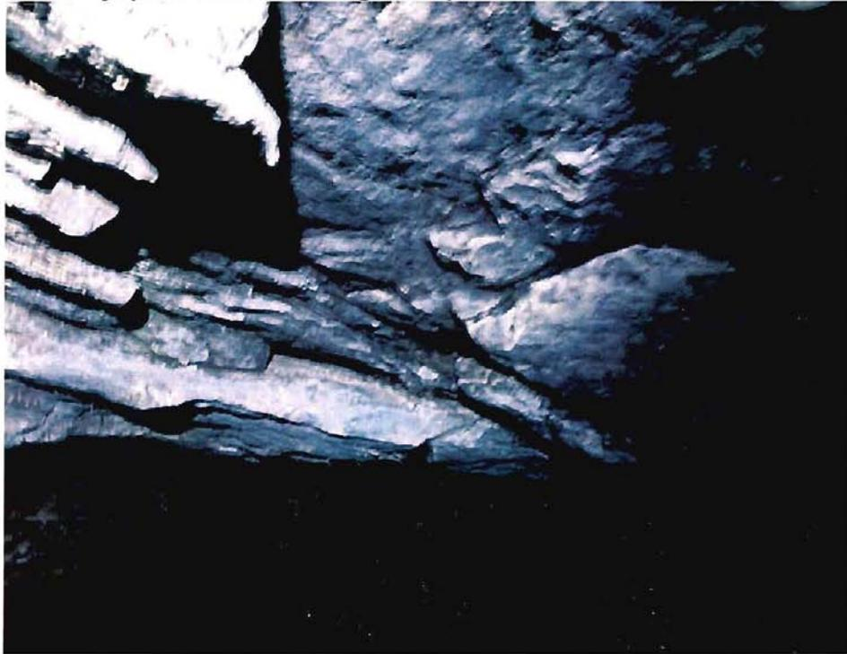
Fotografía 4-10.- Aspecto de la sección del túnel a los 33 m mostrando un perfil rectangular, el que es controlado por fracturas subhorizontales y subverticales más o menos paralelas al trazado del túnel. GPS LR 16.
