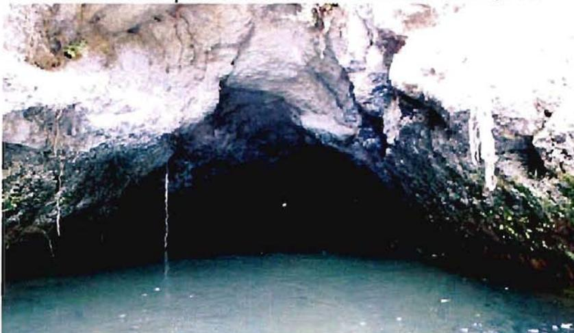
**Fotografía 4-69.-** Detalle del portal de salida del túnel Quilacán 5. Se observa suelo correspondiente a depósitos coluviales en los cuales se excavó el portal. GPS Q5 2.
