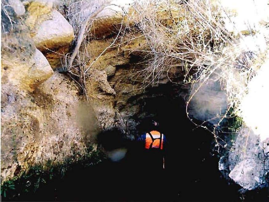
**Fotografía 4-62.-** Vista del portal de entrada del túnel Quilacán 4 mostrando algunos de los sistemas de fractura predominantes en el sector. GPS Q4 1.
