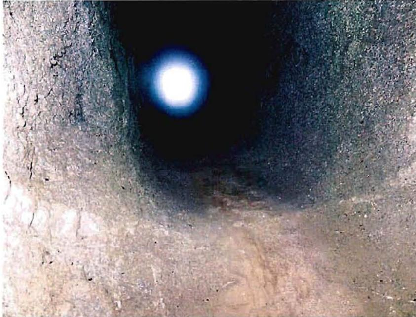
Fotografía 4-30.- Vista de detalle de la segunda “lumbreira”, excavada también en roca granodiorítica. Se aprecian fracturas abiertas con relleno de arcilla blanca y hematita. GPS
