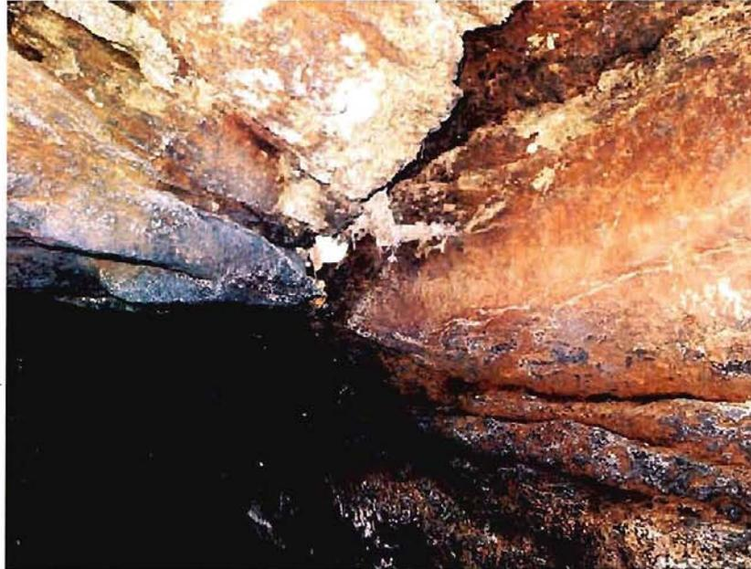
Fotografía 4-14.- Detalle del túnel a los 55 m; se aprecia claramente el nivel del caudal máximo en el costado derecho de la clave del túnel demostrando la entrada en presión frecuente en esta parte del túnel. Se observan, además, bloques grandes y basura retenidos en esta sección del túnel. GPS TB 104.
