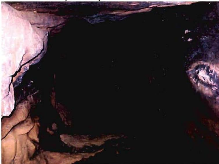
Fotografía 4-13.- Detalle de la pared derecha y clave mostrando una fractura abierta con relleno de basura, en el sector del túnel entre 42 y 57 m, confirmando que este túnel entra en presión en algunas ocasiones. GPS TB 103.
