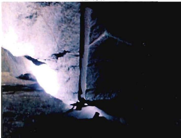
**Fotografía 4-8.- Otro ejemplo de trazas de perforaciones mostrando la dureza de la roca a los 111 m del túnel en el tramo 2. GPS TB 111.**
