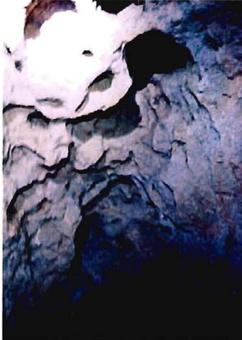
Fotografía 4-40.- Aspecto del portal de entrada mostrando el recubrimiento de maicillo y/o suelo residual. GPS LB 27.
