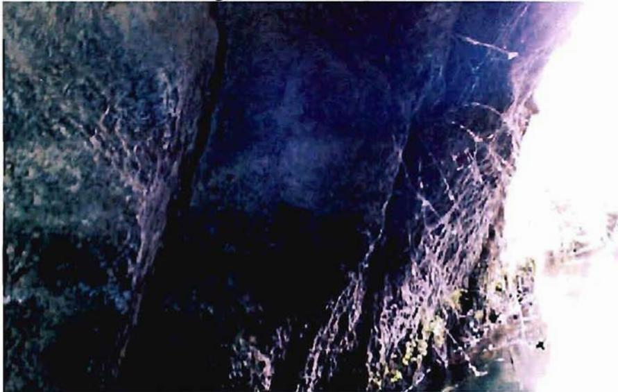
**Fotografía 4-65.- Vista del recubrimiento o sobrecarga del Túnel Quilacán 4 en el portal de entrada. Se reconoce en el primer metro una roca muy meteorizada ( W5 a W6) y luego unos 2,0 metros correspondiente a roca con grado W4 de meteorización. GPS Q4 1B.**
