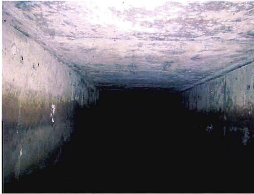
Fotografía 4-89.- Vista de detalle de la clave del túnel en forma de techo a dos aguas, definida por la intersección neta de dos sistemas de fracturas paralelos al túnel en los 370 m desde el portal de entrada. GPS LC 46.
