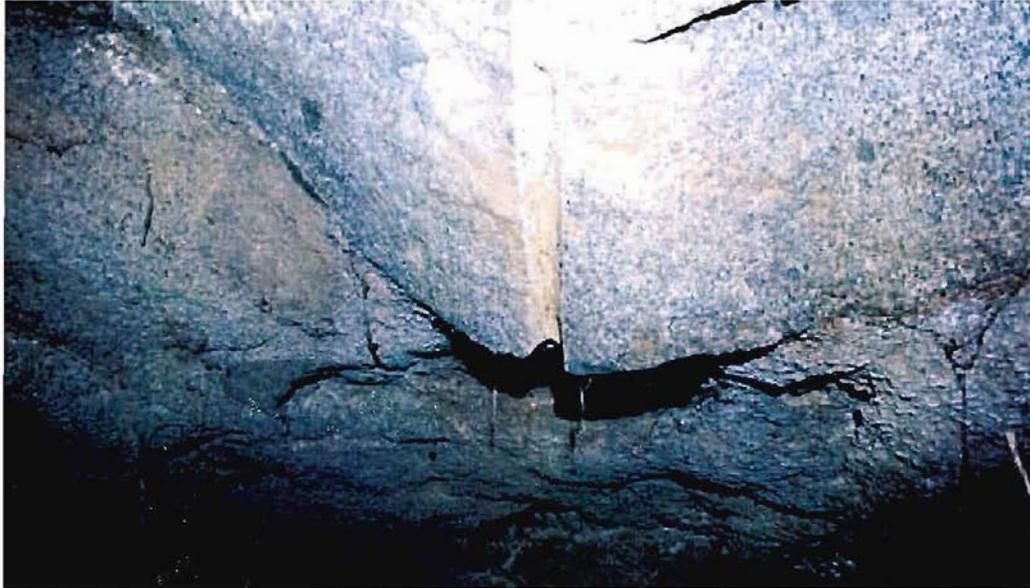
Fotografía 4-56.- Parte central del túnel Quilacán 3 en donde se visualiza la sección del túnel controlada por fracturas subparalelas al túnel. GPS Q3 22.
