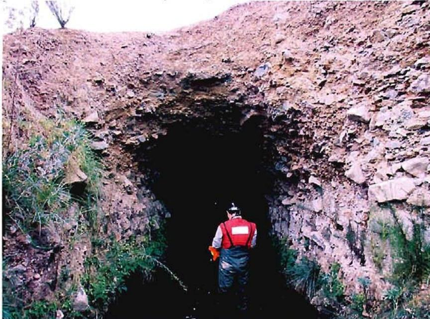
Fotografía 4-75.- Vista del sector del portal de salida del Túnel El Membrillo, mostrando el espesor del recubrimiento y sobreexcavación del portal. GPS EM 37.
