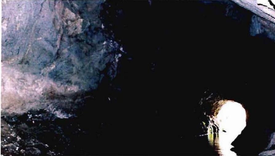
**Fotografía 4-64.- Fracturas visibles en la pared izquierda del túnel, en el portal de salida; se visualizan algunas fracturas abiertas. GPS Q4 36.**
