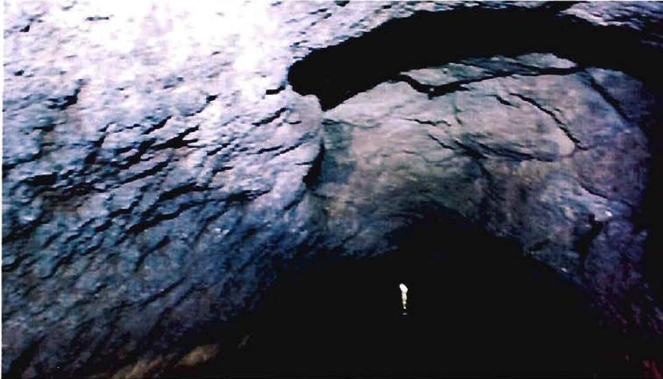
Fotografía 4-71.- Parte media del túnel mostrando la clave más alta, por sobreexcavación del maicillo asociada a la presencia de fracturas. GPS Q5 18.
