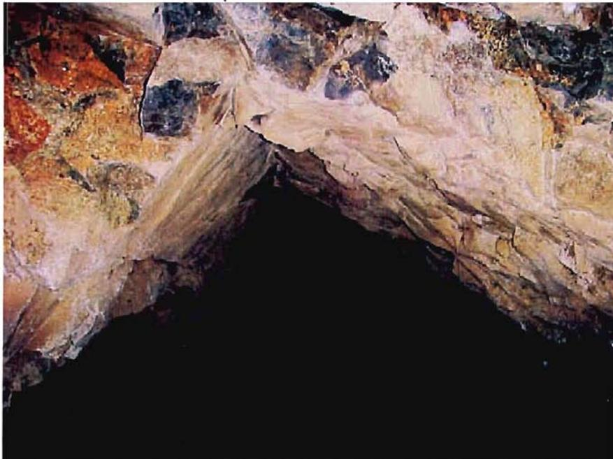
Fotografía 4-90.- Vista de las fracturas que controlan la clave del túnel a los 380 m desde el portal de entrada. GPS LC 44.
