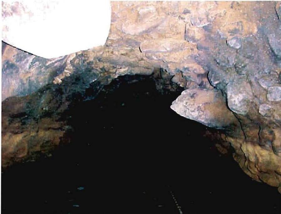
Fotografía 4-86.- Detalle del túnel a los 211 m, en donde se visualiza un gran bloque métrico sobresaliendo desde la clave, GPS LC 69.
