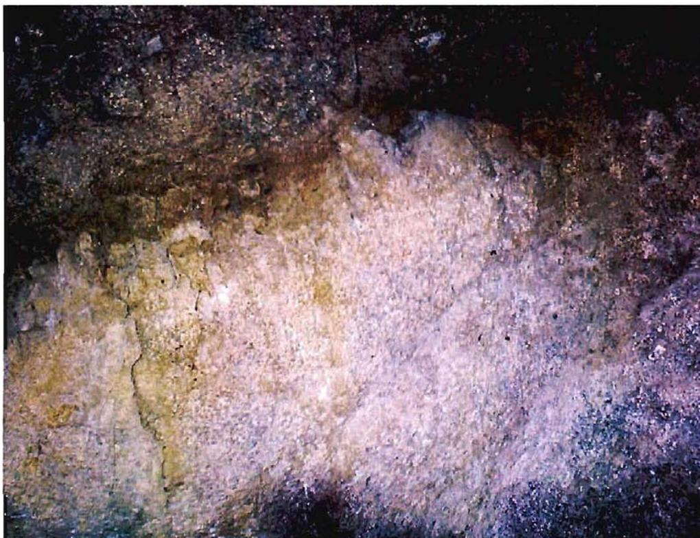
Fotografía 4-27.- Detalle de la pared del túnel a los 586 m mostrando la misma situación que la de la fotografía anterior entre la roca más meteorizada (arriba) y menos meteorizada (abajo). GPS TB 054.
