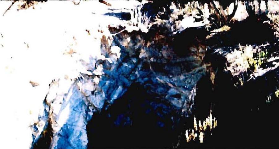
**Fotografía 4-66.- Vista del sector del portal de salida del Túnel Quilacán 4, mostrando una superficie de roca descompuesta parcialmente a suelo residual. GPS Q4.**
