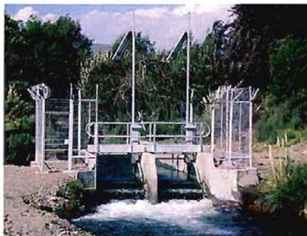
Fotografía N° 1: Compuertas radiales automáticas tipo Flume Gates Canal Bellavista.
