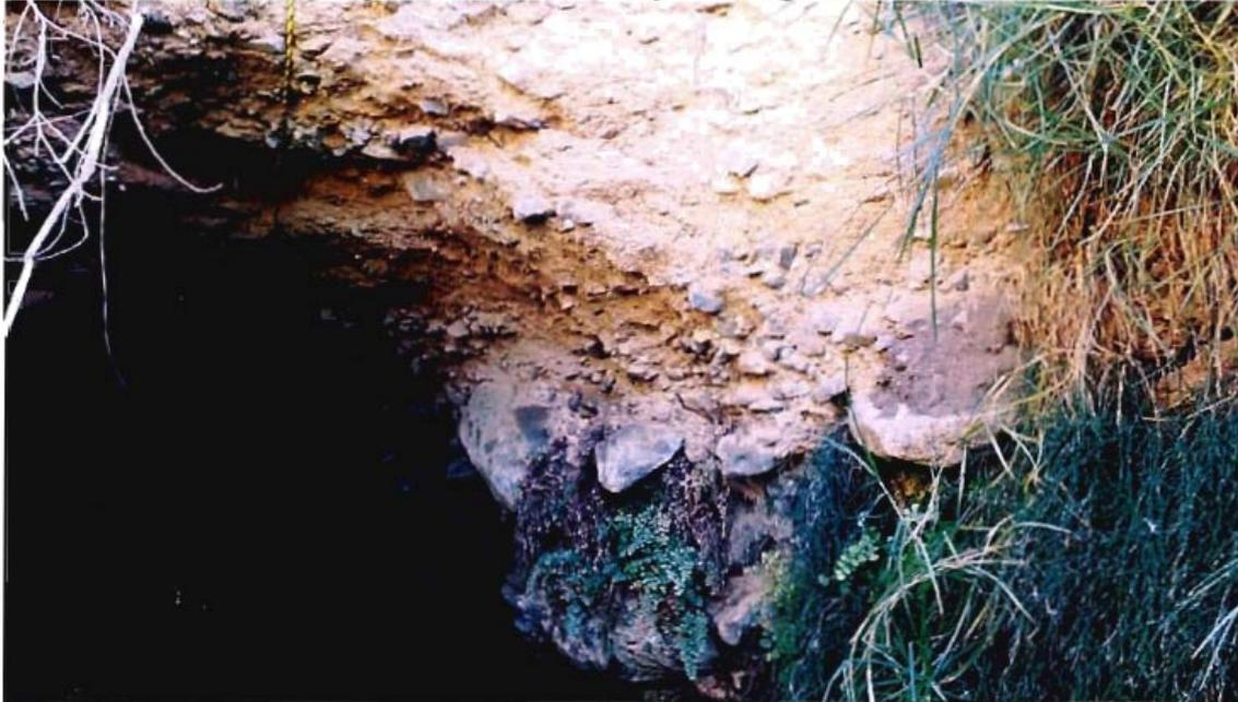
Fotografía 4-23.- Vista de la pared izquierda del túnel a unos 15 m del portal de entrada mostrando el contacto entre la roca intrusiva (abajo) y los depósitos coluviales que muestran además bloques redondeados de rocas graníticas en la base. GPS P 15.
