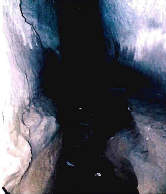
Fotografía 4-35.- Detalle del gran socavamiento en el piso del túnel al inicio del tramo 3, que podría corresponder al sumidero o “cascada”, señalado por los celadores, en los primeros 15 metros, aproximadamente, con una profundidad superior a los 2,5 m. GPS TB 089.
