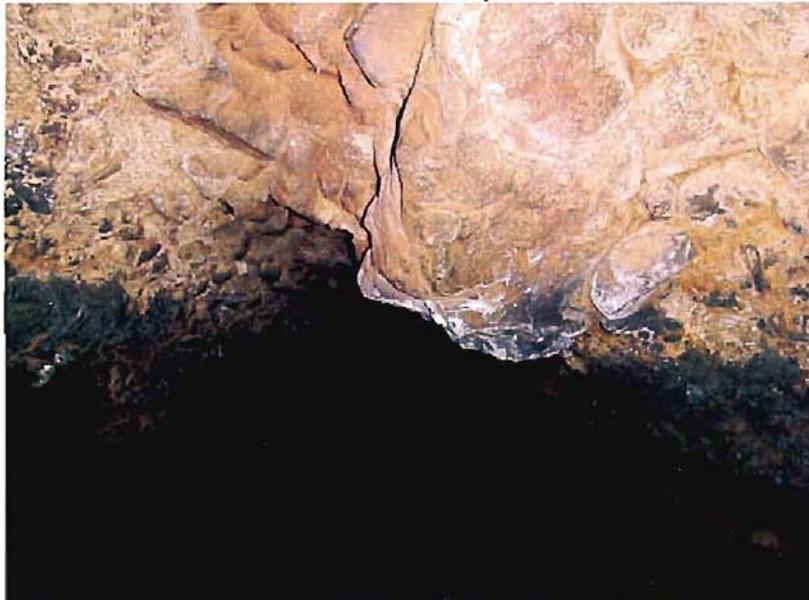
Fotografía 4-84.- Detalle de la clave del túnel a los 105 m, que muestra otro bloque colgante de tamaño métrico. GPS LC 18
