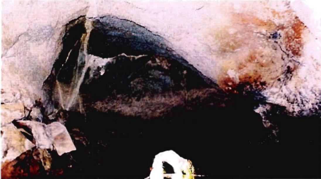
Fotografía 4-58, Detalle de la sobrexcautación de la clave del túnel. GPS Q3 41.
