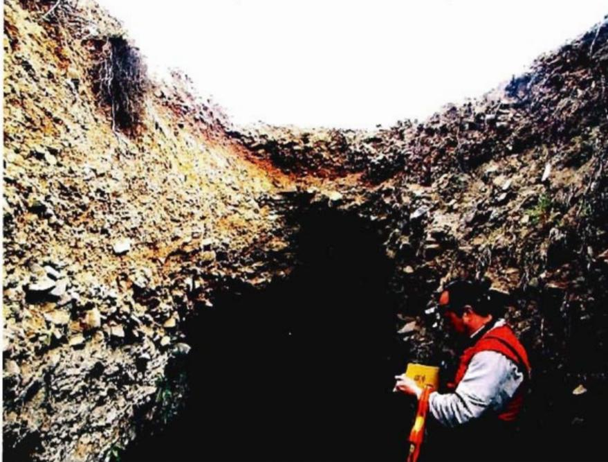
Fotografía 4-76.- Detalle de la “lumbreira” o ducto de ventilación en el metro 181 del túnel excavada en grava arenosa. GPS EM 24.
