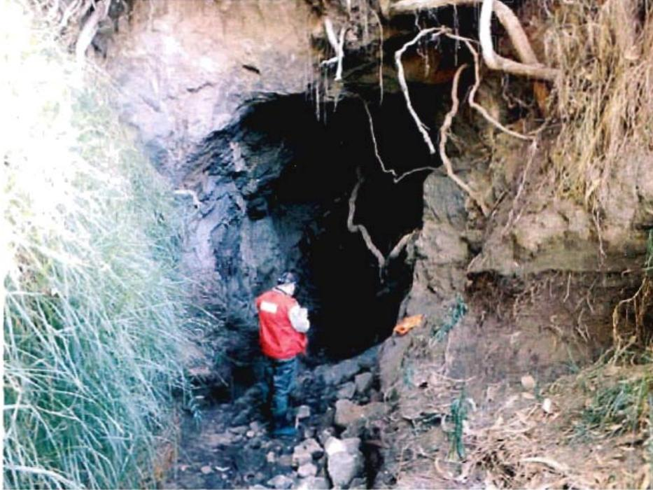
Fotografía 4-3.- Núcleos de roca más fresca con tamaño de bloques colgando de la clave del túnel, en los primeros 28 m. Se aprecia además la gran cantidad de raíces que han atravesado la roca meteorizada. GPS LR 9.
