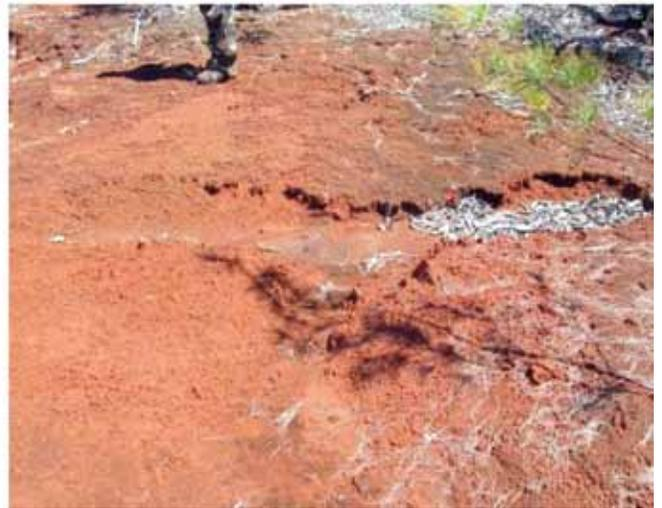
**Figura 37.** Zanjas de infiltración y diques de contención de sedimentos en el sector del Poike , junto a plantación de especies forestales y matorrales.
