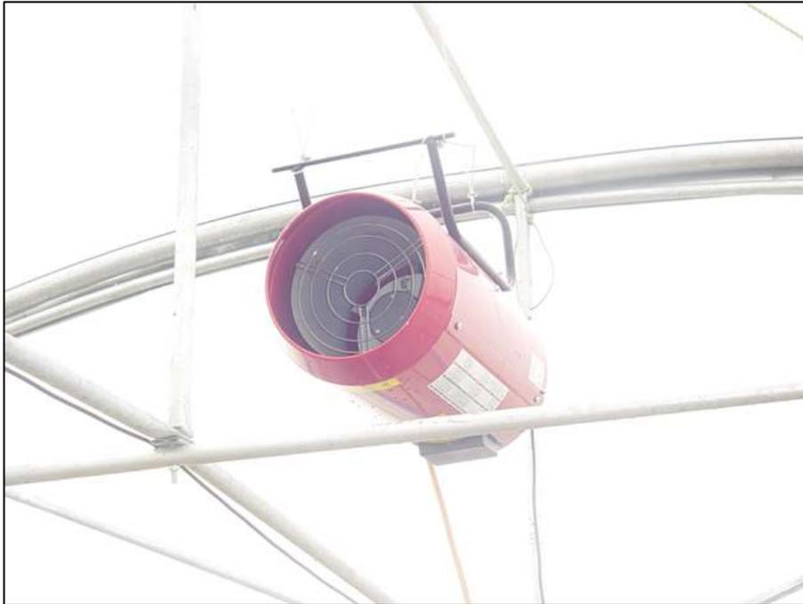
Figura N°7. Calentador de aire para mantener una producción en ambiente controlado.
