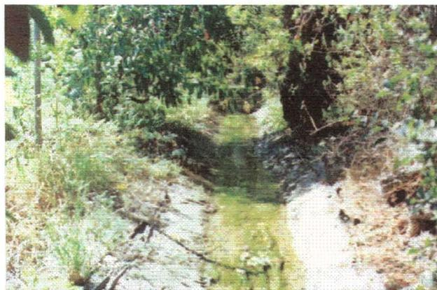
**Foto 3. Canal revestido.** Trayecto del canal (derivado del Cerro) revestida con hormigón y con sección cóncava.
