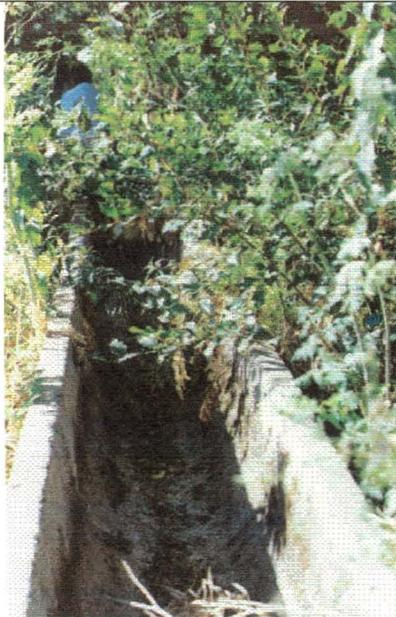
**Foto 7. Revestimiento canal.** Derivado del bajo con sección revestida en hormigón.
