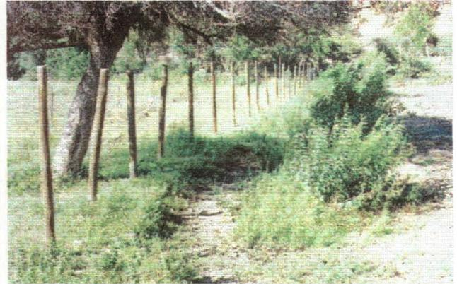
**Foto 6. Derivado del bajo.** Sector con baja mantención y filtraciones evidenciadas por la vegetación.
