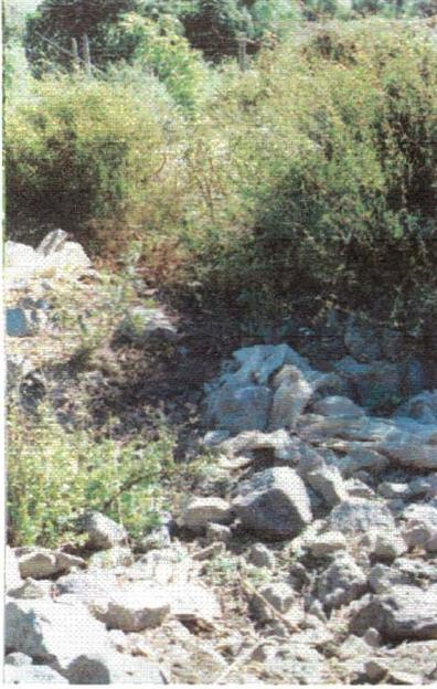
**Foto 5. Entrega predial.** Taco de piedras y plástico usado como estructura de entrega predial. Hasta este punto se observa que el canal es utilizado, pero con una mantención mínima.
