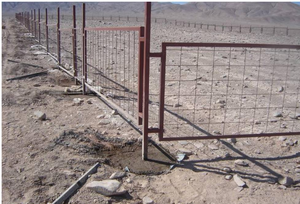
Figura 46: Luego se rellenan con hormigón los pilares del cerco.
