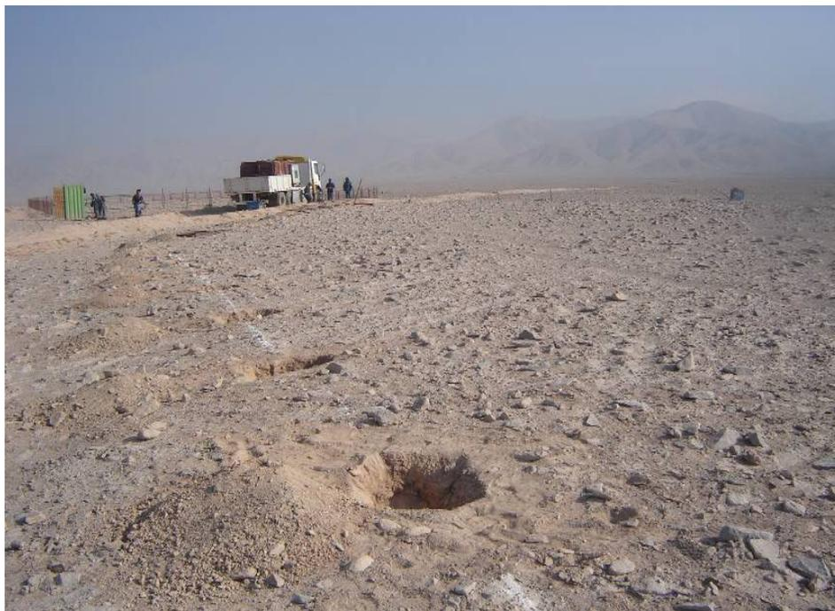
Figura 43: Excavación de pozos para el posterior anclaje de las estructuras.
