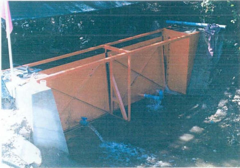
Cuando llegue el período de lluvia, la estructura se desarma cuidadosamente. La foto muestra como se desprende la lámina central, desaguando previamente el agua acumulada en la microcuencal.-
