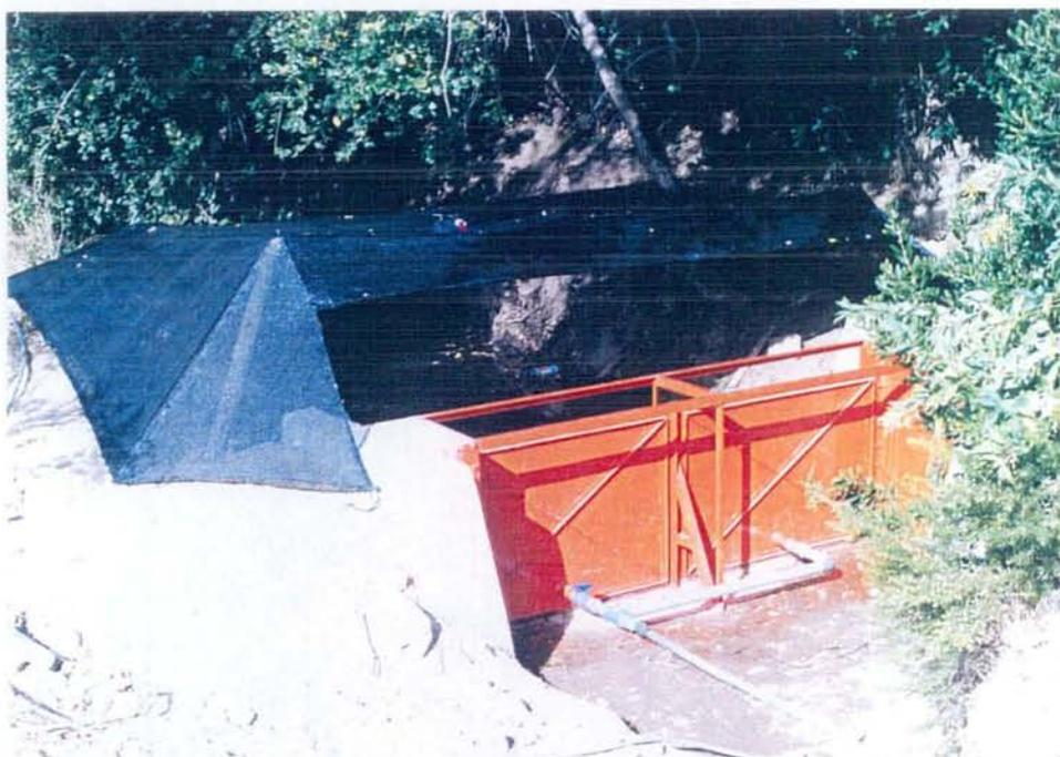
La obra terminada se protege del sol para evitar pérdidas por evaporación y elevar la temperatura del agua, que favorece el desarrollo de pequeños microorganismos y algas, que afectan la calidad de riego del agua captada.-
