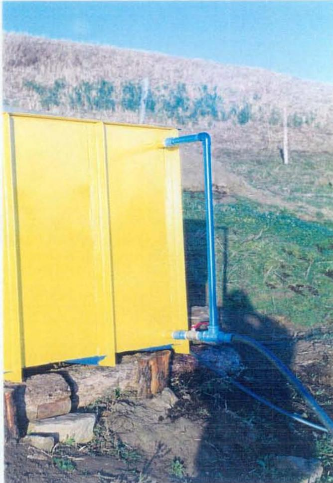
Cada acumulador metálico posee un "vertedero" en su borde superior, el cual descarga el agua delante de la válvula, si el caudal nocturno supera la capacidad del acumulador, llegando las aguas sobrantes a las zonas de riego antes que escurran por sobre la estructura.
