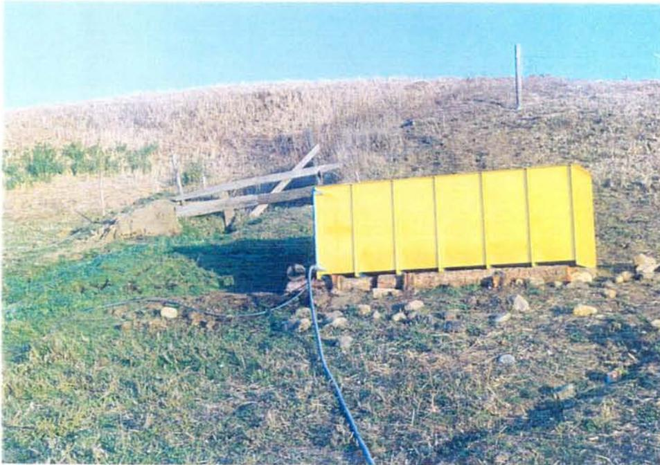
El diseño y la construcción y diseño, de acumuladores nocturnos metálicos, para almacenar el agua de las vertientes en zonas altas, permitió mejorar el riego presurizado gravitacional en el secano costero.-
