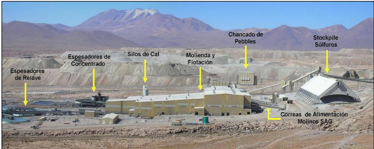
El concentrado de cobre final, proveniente del circuito de flotación de limpieza, será alimentado a un espesador de concentrado. Luego, será enviado a los estanques de almacenamiento, desde donde, a través de bombas será impulsado a través los mineroductos de 7" y 8" hacia las instalaciones en Puerto Patache.
