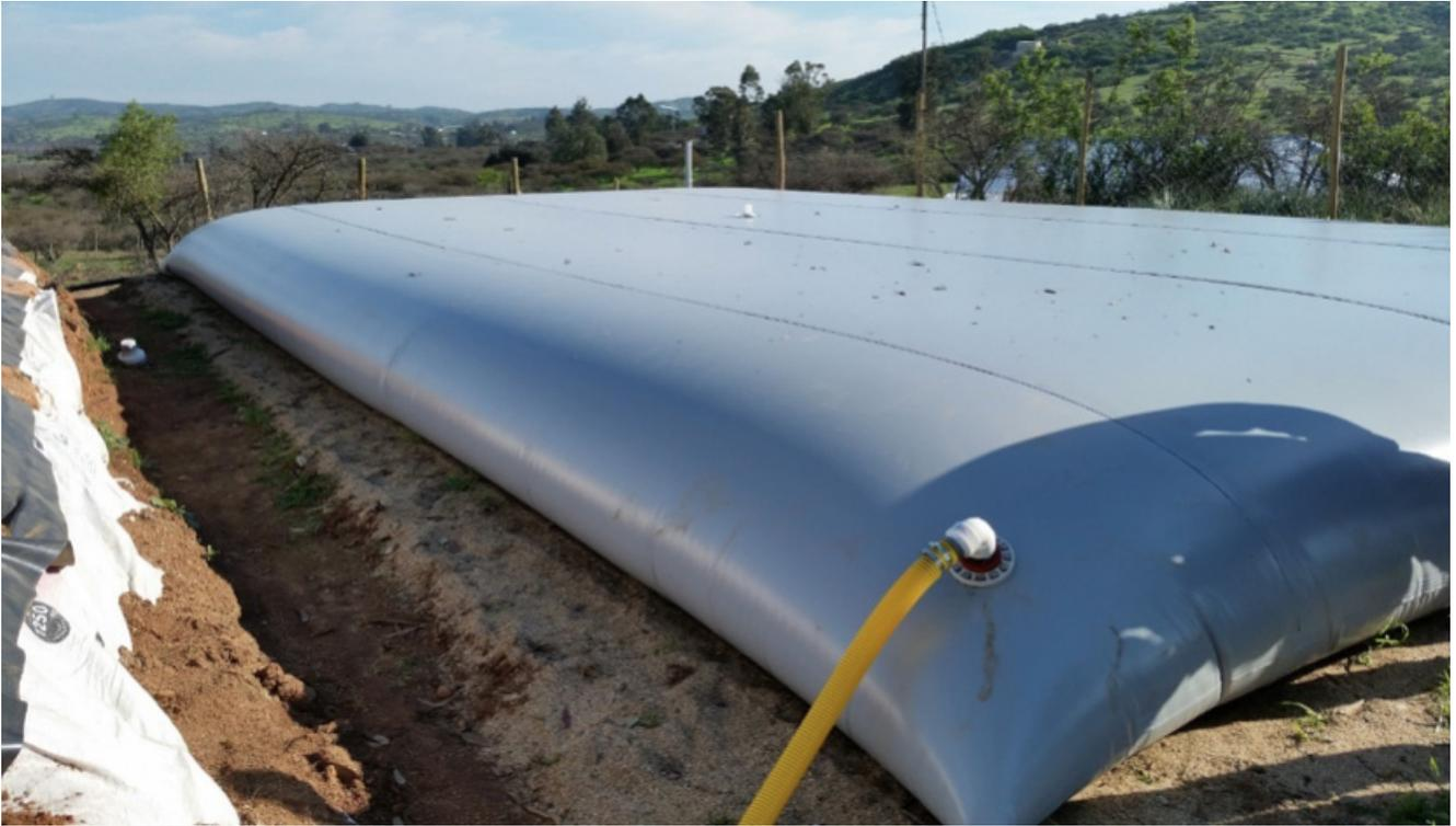
**Fotografía 19.** Uno de los módulos demostrativos instalados en sector El Prado, perteneciente al productor Luis Jerez. Se puede observar una cisterna flexible de 100 m<sup>3</sup> para el riego en la producción de frutillas.
