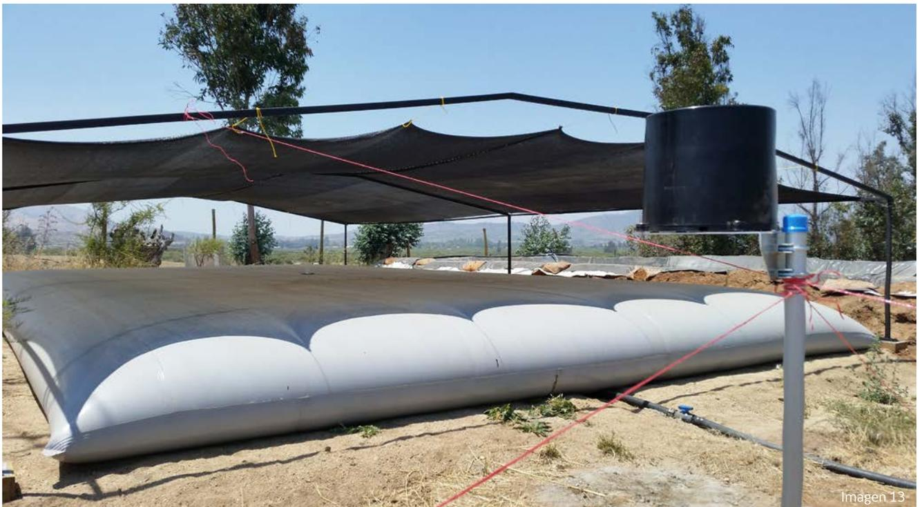
En las imágenes 12 - 13, se muestra la cisterna flexible ya implementada, junto a todas las conexiones hidráulicas, estructura de techo con malla raschel, kit fotovoltaico e instrumental pluviómetro.
