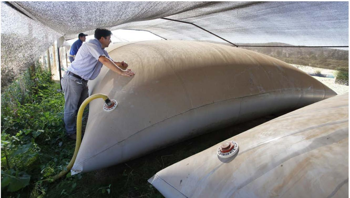
**Fotografía 18.** Uno de los módulos demostrativos instalados en sector Lo Encañado, perteneciente al productor Víctor Álvarez. Se pueden observar dos cisternas flexibles, una de 25 m<sup>3</sup> y una de 50 m<sup>3</sup>, utilizadas para el riego en la producción de frutillas.
