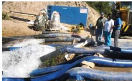
La obra de bombeo extrae agua del Canal Maule Norte Bajo y a través de una elevación la lleva al Canal Maule Norte Alto. Hasta ahora los altos costos de la solución de bombeo están siendo cubiertos por la Asociación de Canalistas, lo que incluye el arriendo de tres generadores y de las 14 motobombas, así
