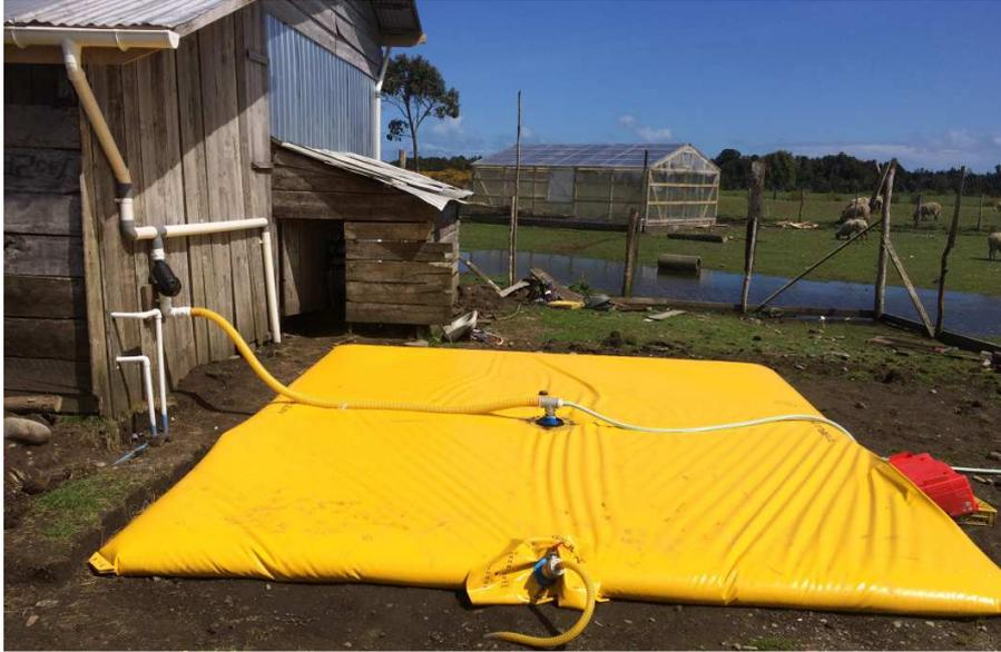
Figura 20. Instalación de Captación en techo de Galpón, Acumulador Flexible e invernadero.
