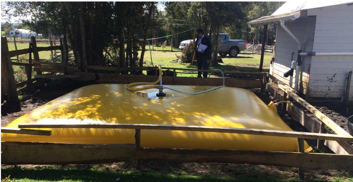
Figura 25. Captación aguas lluvias y acumulador flexible.
