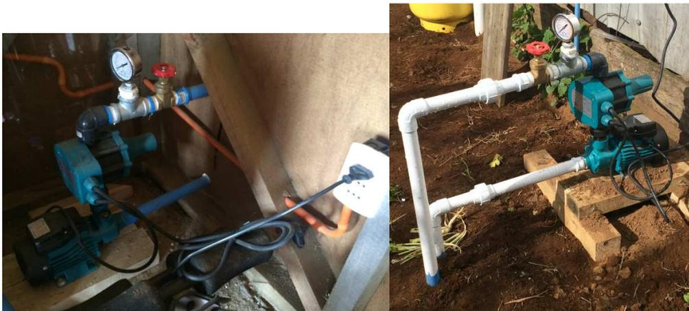
Figura 9. Instalación de electrobomba dentro de galpón y al aire libre.
