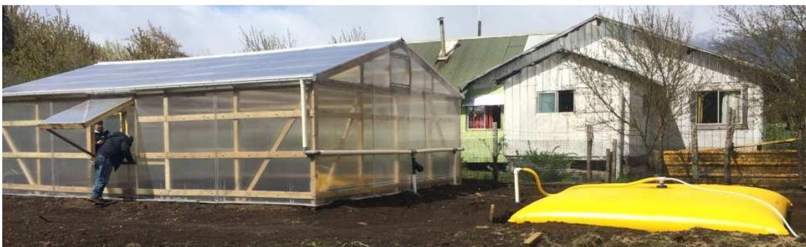
Figura 7. Instalación de Sistema Captación y acumulación sin diferencia de nivel entre acumulador e invernadero..
