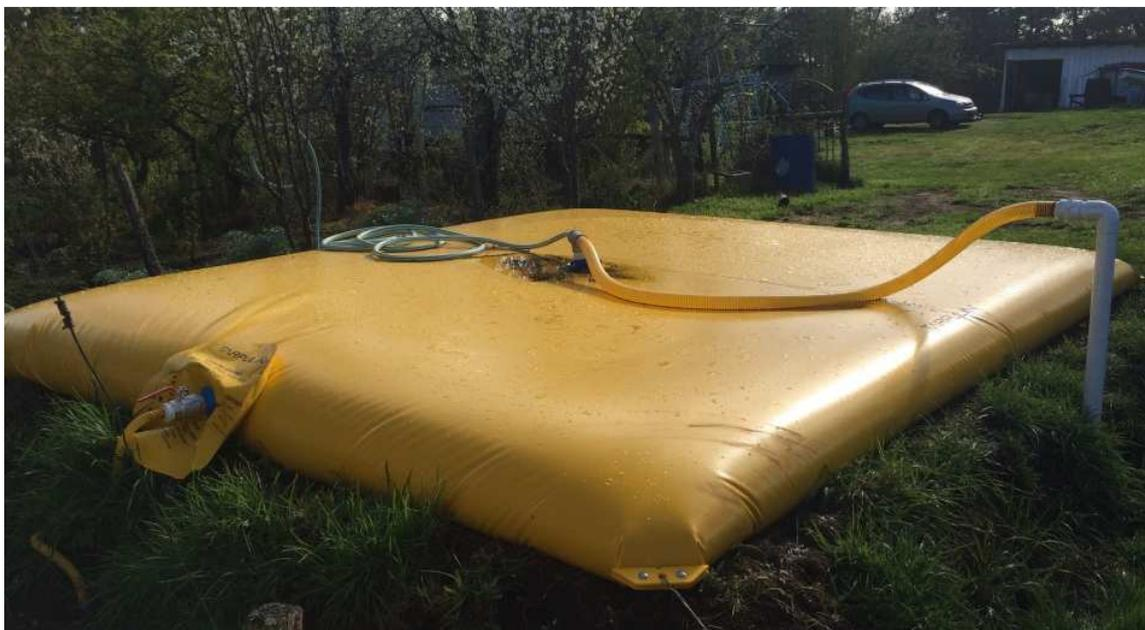
Figura 17. Instalación de Acumulador Flexible sobre terraplén.
