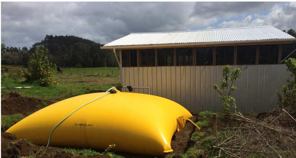
Figura 19. Instalación de Captación en techo de Galpón y Acumulador Flexible.
