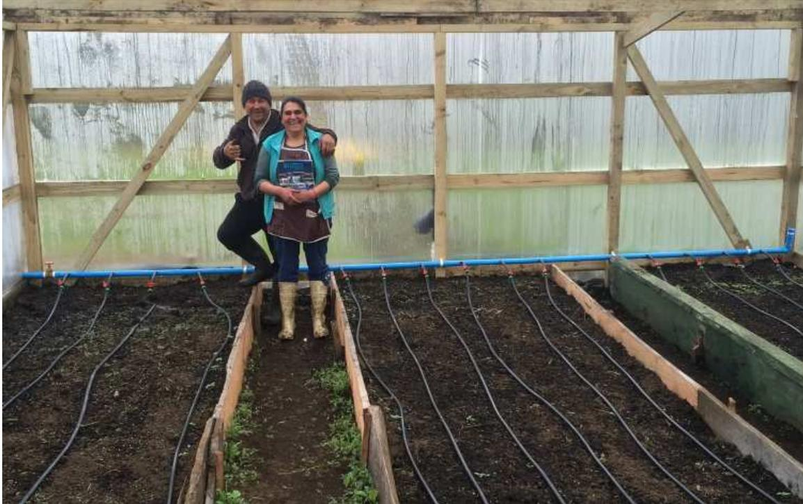
Figura 24. Sistema de riego por cintas en invernadero.
