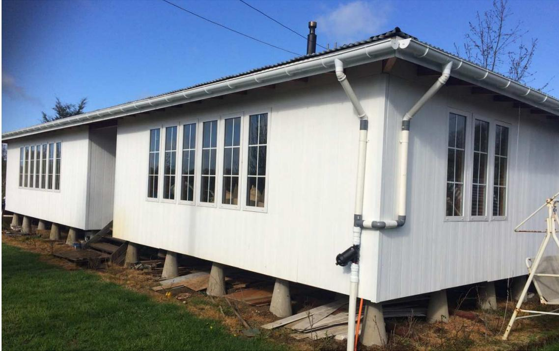
Figura 26. Sistema de Captación aguas lluvias.
