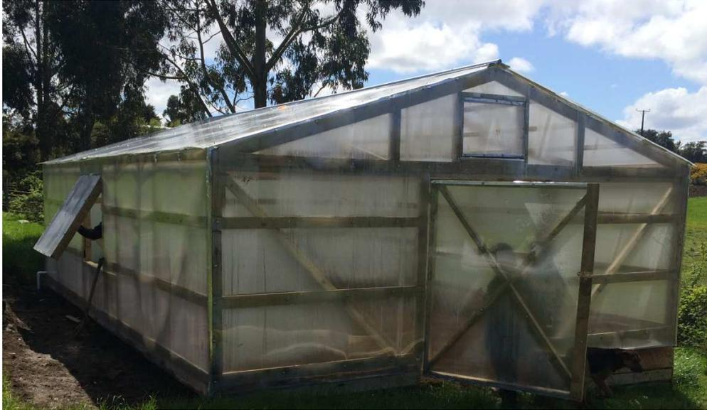
Figura 22. Invernadero estructura de madera, cubierto con plancha de policarbonato.
