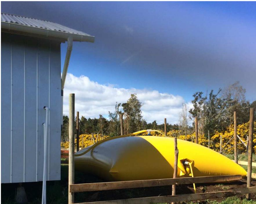
Figura 21. Instalación de Captación en techo de Galpón y Acumulador Flexible a plena capacidad.
