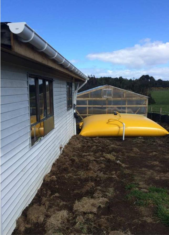
Figura 10. Sistema de Captación de aguas lluvias, acumulación e invernadero sin diferencia de cota.
