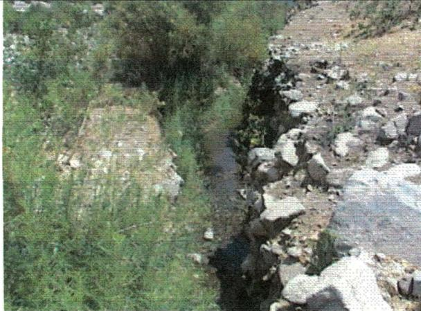
Foto N° 3: Sección sin Revestimiento Canal Los Loros
