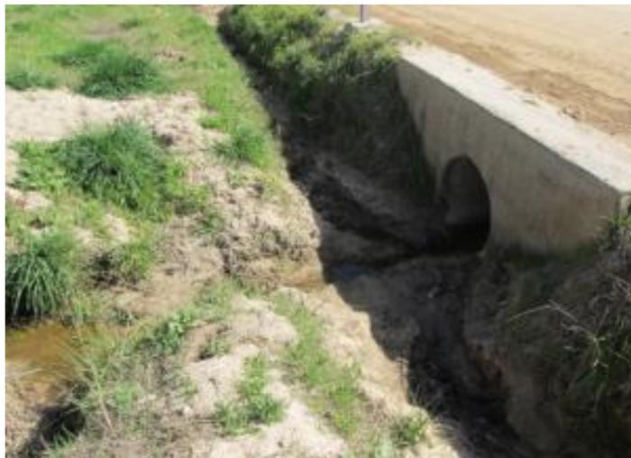
Ilustración 19: Vertedero Abandonado Litueche - Litueche - Parte baja, canalización bajo camino rural.
