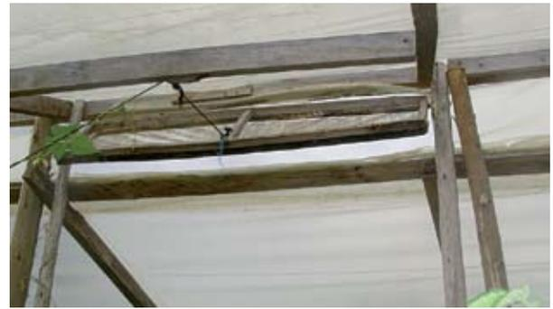
*Canaleta:* El ancho de la canaleta varía entre 80 a 100 cm y sirve para recoger las aguas lluvia.
