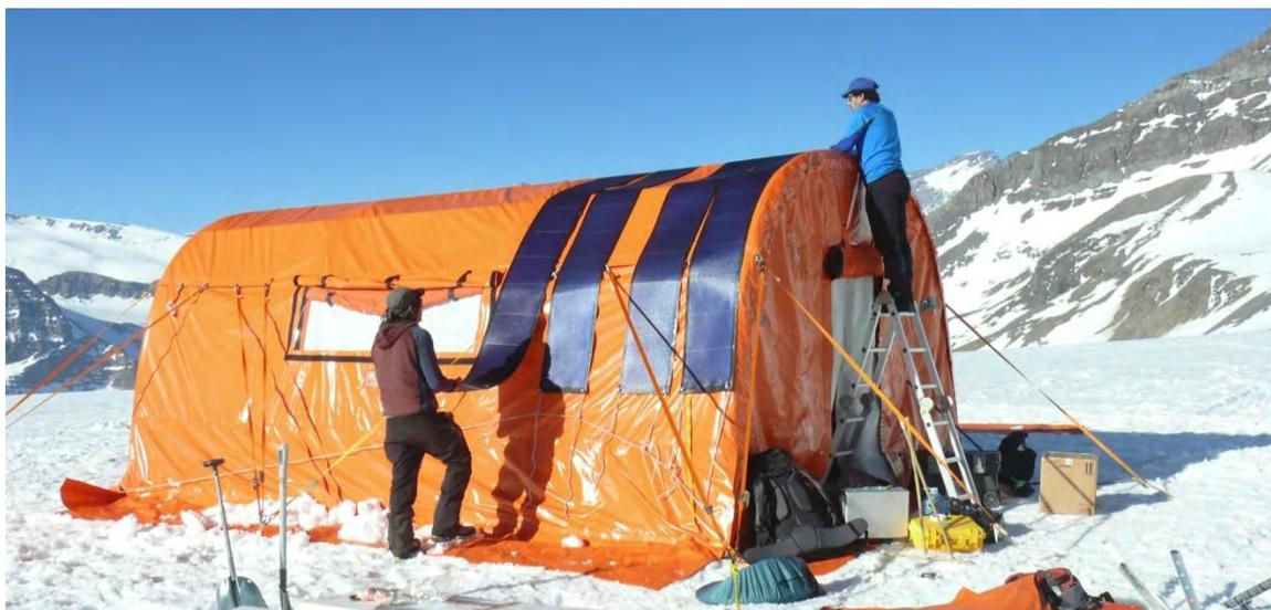
Figura 19: Carpa hangar utilizada por el CETAM para el campamento e instalación de paneles fotovoltaicos flexibles.
