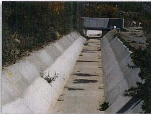
**Imagen N° 4: Vista Canal Abierto sección trapecial Canal Alimentador.**
