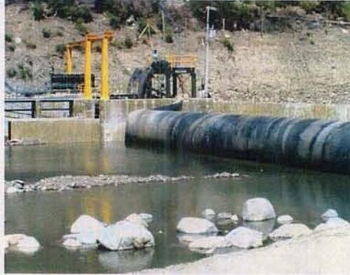
**Imagen N° 3: Vista Ruber Dam Bocatoma Canal Alimentador Embalse Corrales.**
