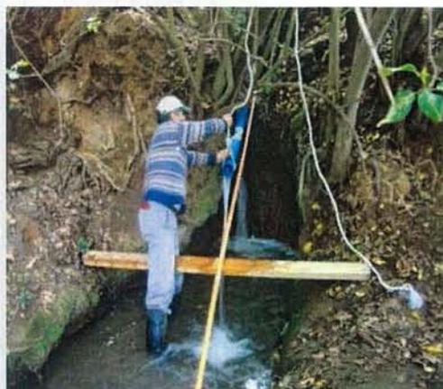
**Imagen N° 19: Profesional del Programa instalando tubería para medir el caudal.**
