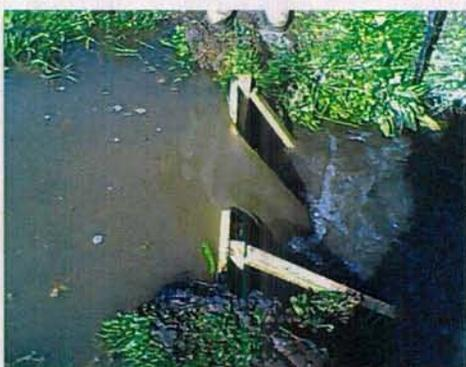
**Imagen N° 13: Vertedero triangular funcionando en óptimas condiciones.**
