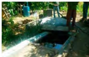
Figura 10: Biodigestor de domo flotante tipo Hindú. Fuente: Biotecsur.
