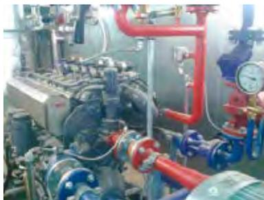
**Figura 18:** Co-generación con grupo electrógeno de 200 KW a biogás en planta de Genera Austral.
