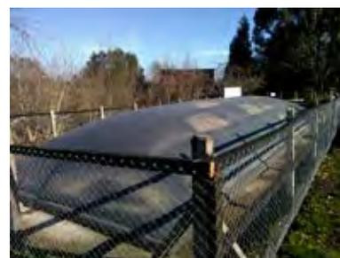
**Figura 23:** Sistema de Biodigestión Predial para 40 vacas, Chiscailhue, 2015.
