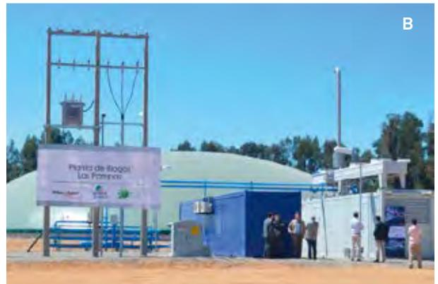
Figura 16 (A - B): Biodigestor sistema estructura hormigón, domo flexible, agitación constante y calefacción.
