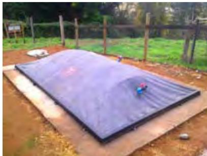
**Figura 27:** Biodigestor domiciliario de estructura rígida y cúpula flexible, para 20 cerdos, biogás para cocinar, 2008.
