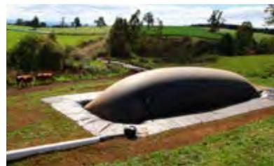
Figura 11: Biodigestor de estructura flexible. Fuente: Biotecsur.
