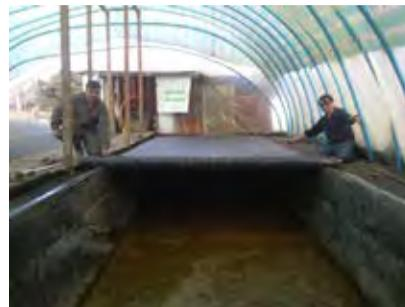
**Figura 28:** Biodigestor estructura flexible para 80 vacas, Puyehue, 2013.
