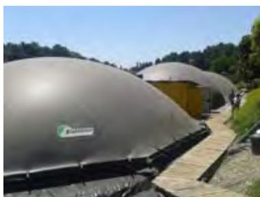
**Figura 20:** Biodigestores de material flexible tipo laguna, en la Región de los Lagos, 2010.
