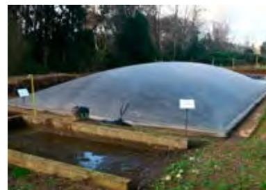
**Figura 24:** Biodigestor estructura flexible tipo laguna, Reumen, 2015.
