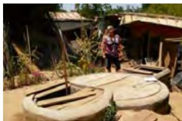
Figura 9: Biodigestor de domo fijo (tipo chino), Sector Coltauco. Fuente: Biotecsur.
