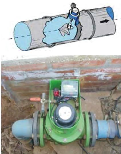
**Figura 30.** Medidor volumétrico.
