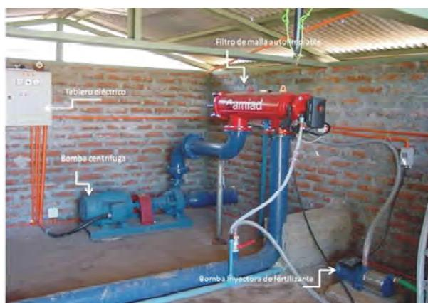
**Foto 12a.** Filtro de malla de retrolavado automático.
