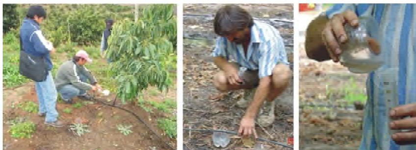
**Foto 23.** Aforo de goteros y microaspersores.
