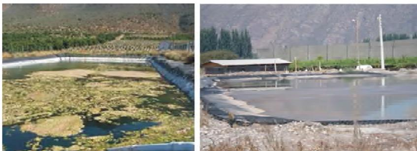
**Foto 25.** Izquierda, tranque con algas. Derecha tranque que está cubierto con una malla que reduce el paso de la luz disminuyendo el desarrollo de algas. Los reservorios o tranque de poca profundidad (1 m) desarrollan más algas que los que tienen un espejo de agua superior a los 2 m.
