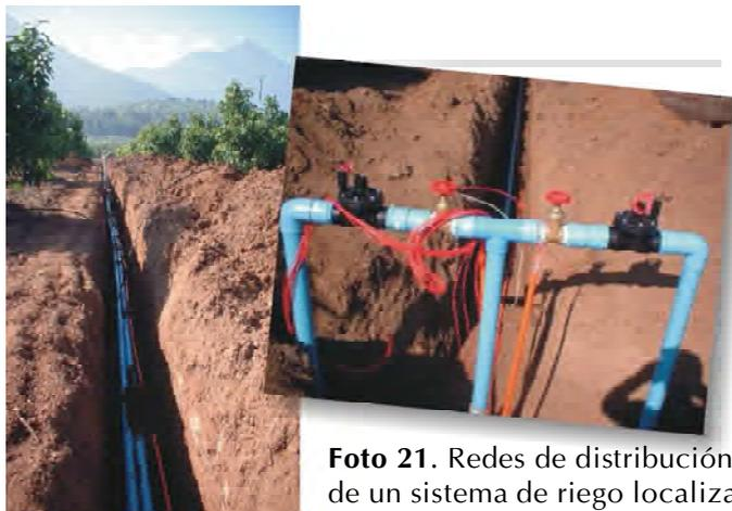
**Foto 21.** Redes de distribución de un sistema de riego localizado.
