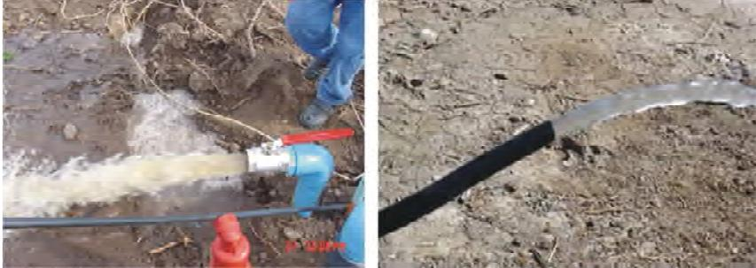
**Foto 24.** Lavado de la red de riego con eliminación del agua en la submatriz o terciaria (izquierda) y fin de laterales (derecha).
