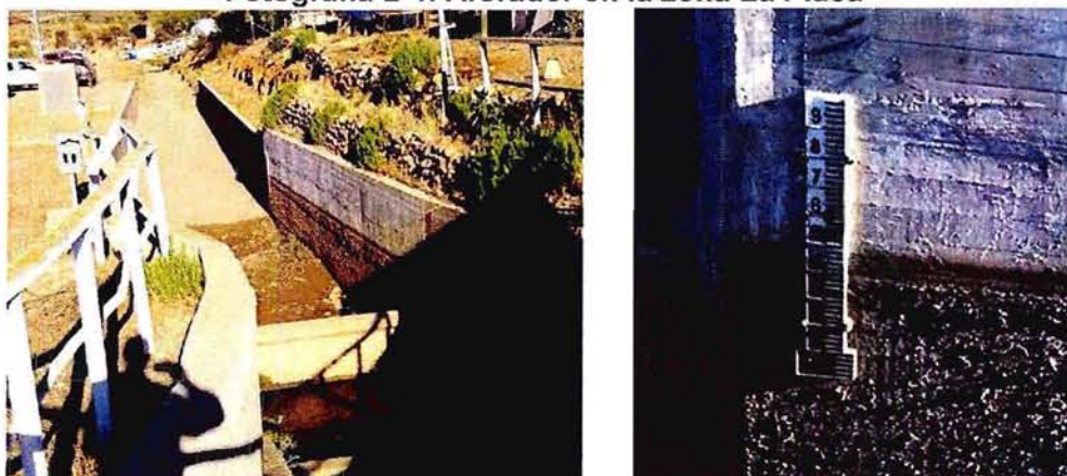
Fotografía 2-4: Aforador en la zona La Placa
