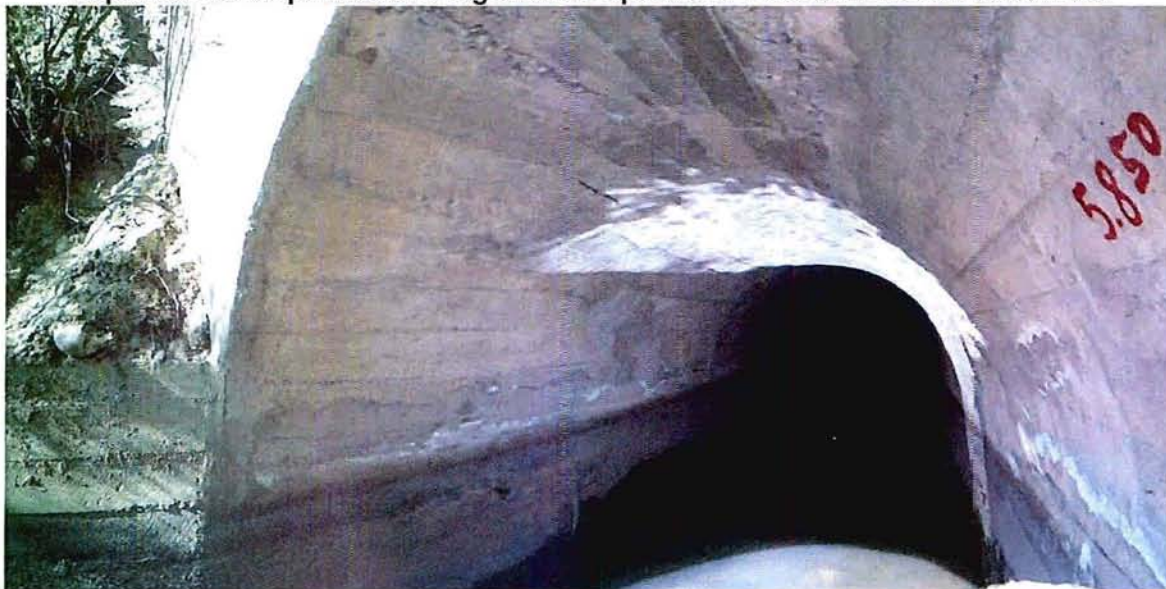
Fotografía 4-4.- Vista de la salida de un túnel del canal Villalón ubicado en la ladera izquierda de la quebrada El Ingenio. Se aprecia el revestimiento de la bóveda.
