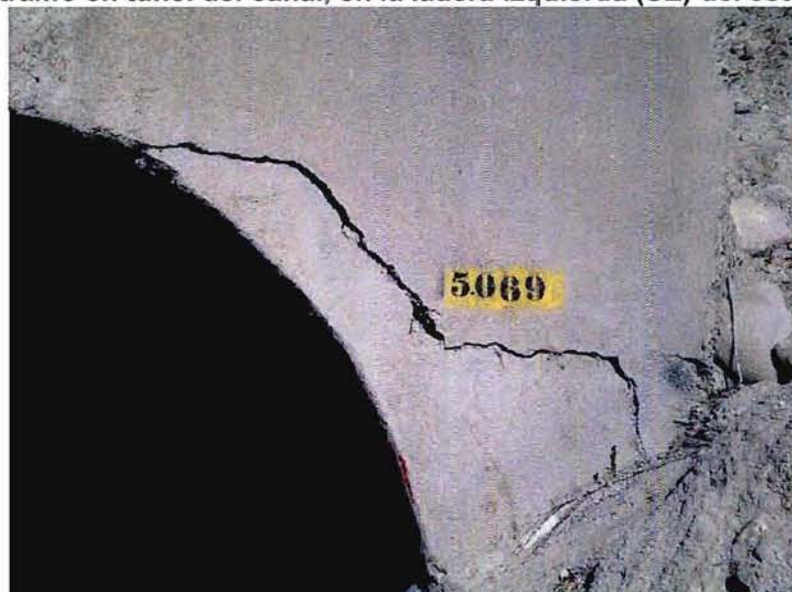
Fotografía 2-6.- Vista de detalle de colapso parcial del revestimiento en el portal de salida de un tramo en túnel del canal, en la ladera izquierda (SE) del estero El Ingenio.
