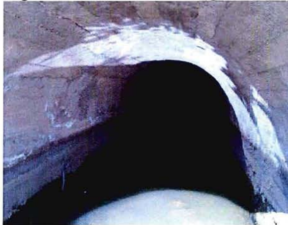
Fotografía 4-2: Acumulación de agua en el túnel
