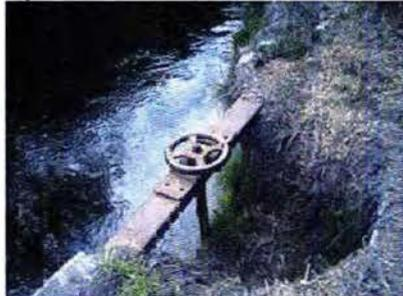
**Fotografía 6-3 Compuerta CP21 con embancamiento y vegetación**
