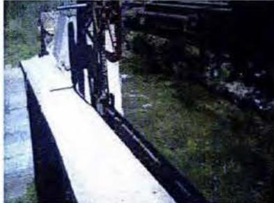
**Fotografía 6-2 Compuerta CP15 con embancamiento y vegetación**
