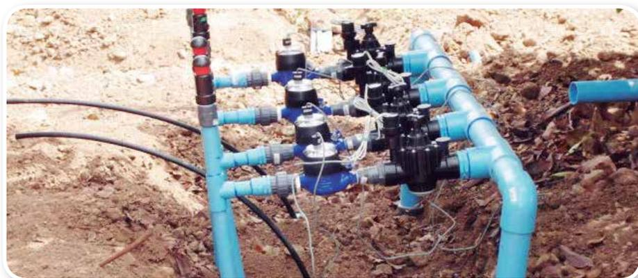
Figura 19: Sistema de control y registro de riego instalado para la aplicación de los tratamientos en Sotaquí.
