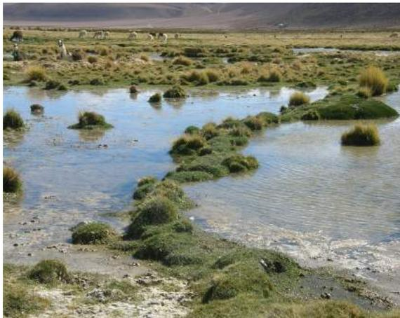
Dique de champas construido para reducir la velocidad del agua e incrementar la infiltración y humectación
