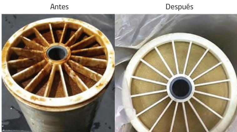
Dependiendo del tamaño de la planta de osmosis, la limpieza puede realizarse manual o automáticamente, utilizando la modalidad CIP (cleaning in place) sin desarmar los bancos de membranas. Sólo en casos de extrema suciedad y deterioro, las membranas se extraen de los contenedores (portamembranas) y se limpian con soluciones químicas de lavado.
