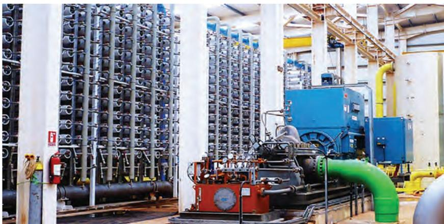
Las membranas espirales (módulos) se instalan en el interior de portamembranas o tubos de presión. En un tubo de presión se suelen colocar entre 3 a 8 membranas, las que se conectan entre sí instalando tubos colectores de permeado para formar un conjunto estanco. Los módulos se disponen en arreglos en serie o en paralelo, diseño que debe ser previamente calculado con el objetivo de obtener la mayor producción posible de agua purificada.
