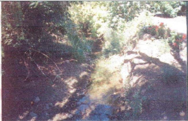
**Foto 10. Sección.** Apozamientos por falta de pendiente en punto de descarga del pozo La Paloma.
