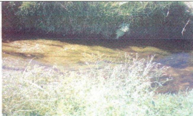
**Foto 12. Sección.** Detalle de sección del canal donde se observa enmalezamiento y presencia de saucillo en el fondo.
