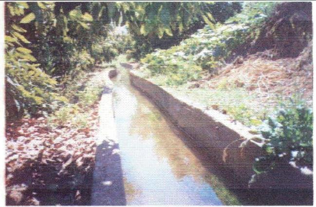
**Foto 14. Tramo 2 Revestido.** Sección rectangular revestida en hormigón.
