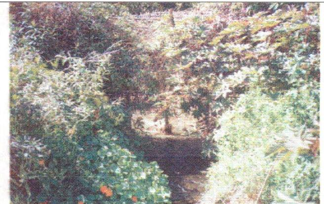
**Foto 4. Sección.** Cercos al interior del canal obstruyen el paso del agua. Punto a 6 m del primer tramo revestido.
