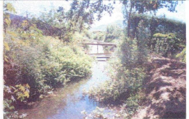
**Foto 8. Sección.** Apozamientos por desnivel antes de quebrada y enmalezamiento del canal.
