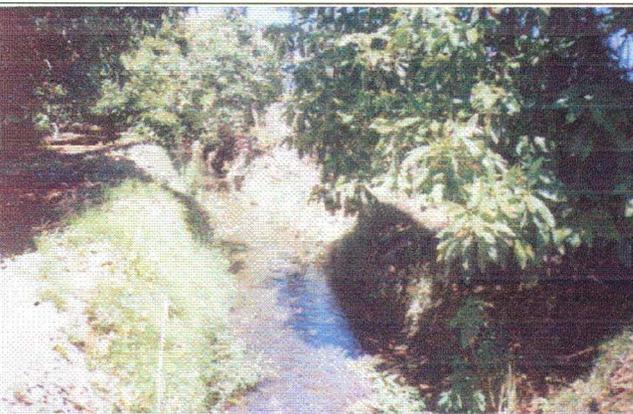
**Foto 5. Sección.** Apozamientos por falta de pendiente y acumulación de hojas.
