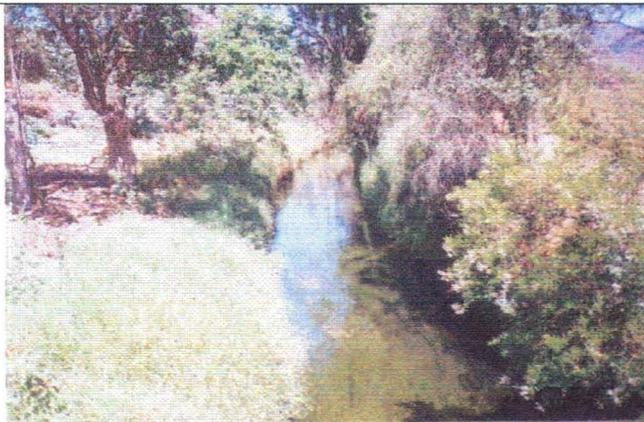
**Foto 17. Sección.** Tramo del canal con baja pendiente y enmalezamiento generalizado.
