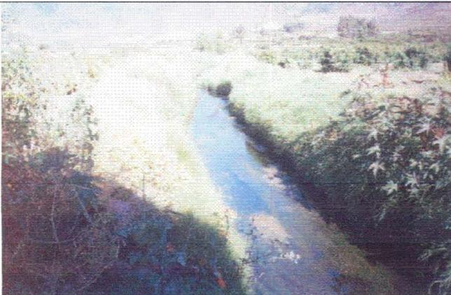
**Foto 15. Sección.** Tramo del canal donde termina baja pendiente. Se observa enmalezamiento generalizado.
