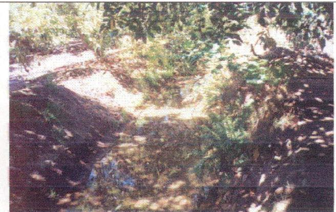
**Foto 6. Sección.** Acumulación de hojas y falta de mantención.
