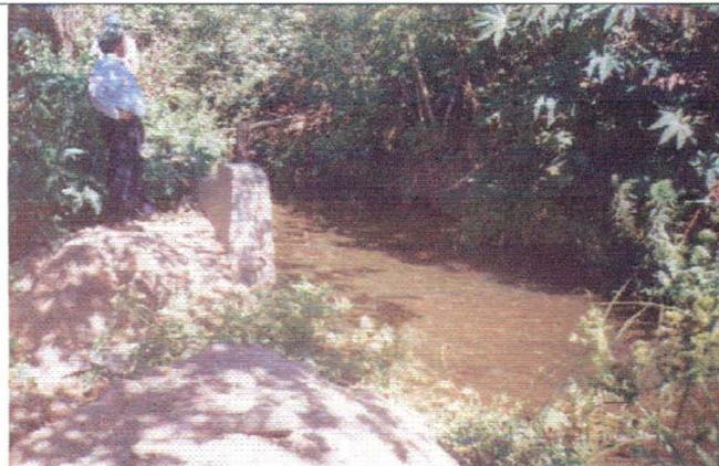
**Foto 9. Sección.** Cortes del canal por paso de quebrada, además se producen filtraciones.
