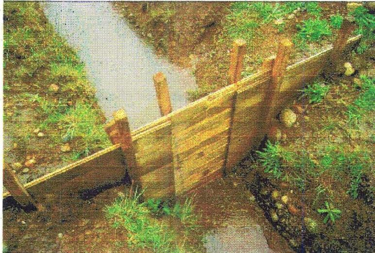
**Fotografía 1. Prototipo de Compuerta de Control del Drenaje.**
