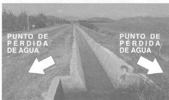
Fotografía 1: La loseta es muy frágil en la sección del terraplén y será fácilmente un punto de salida de agua.
