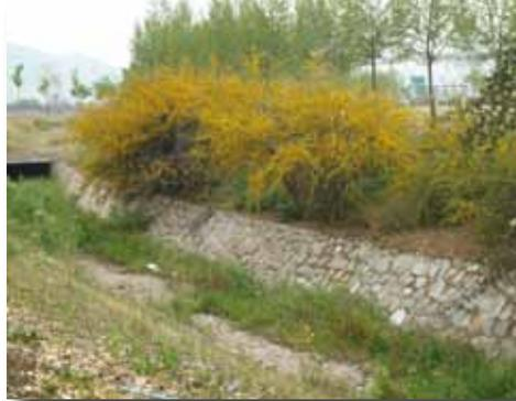
Foto 28: **Espinos plantados en taludes de canal.**
