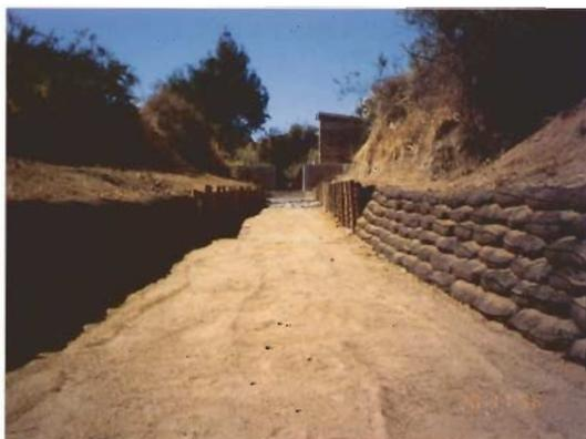
● Vista en perspectiva de tratamientos de control y estabilización de taludes mediante muros de sacos.
