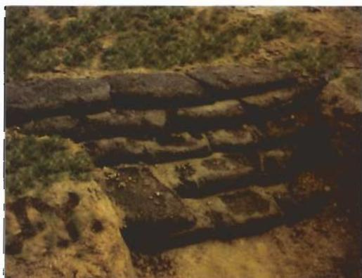
● Vista en detalle de tratamientos con muros de sacos para el control de taludes.
