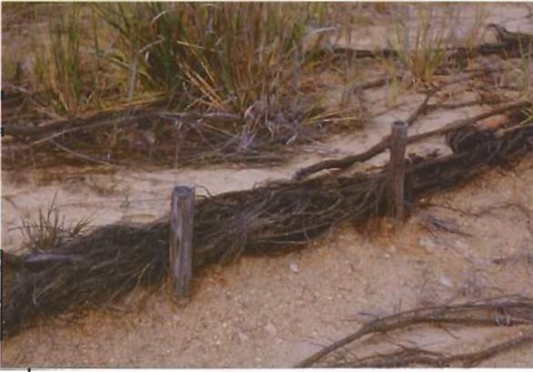
Visión detallada de tratamiento lineal mediante ramas.
