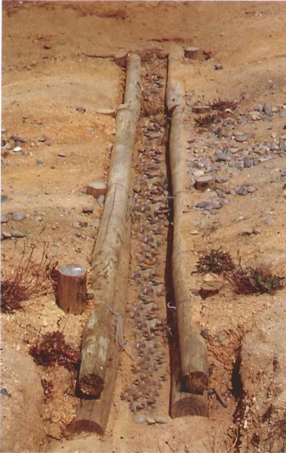
Vista lateral de un canal transversal compuesto en fase de operación con sedimentos acumulados. Para conservar la efectividad de estos tratamientos se requiere de un mantenimiento periódico.
