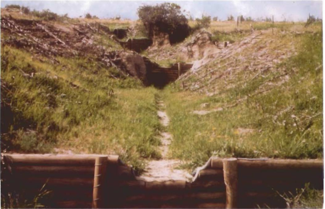
Vista general de un tratamiento de cubierta con caña de maíz combinado con diques de madera en fase de estabilización.
