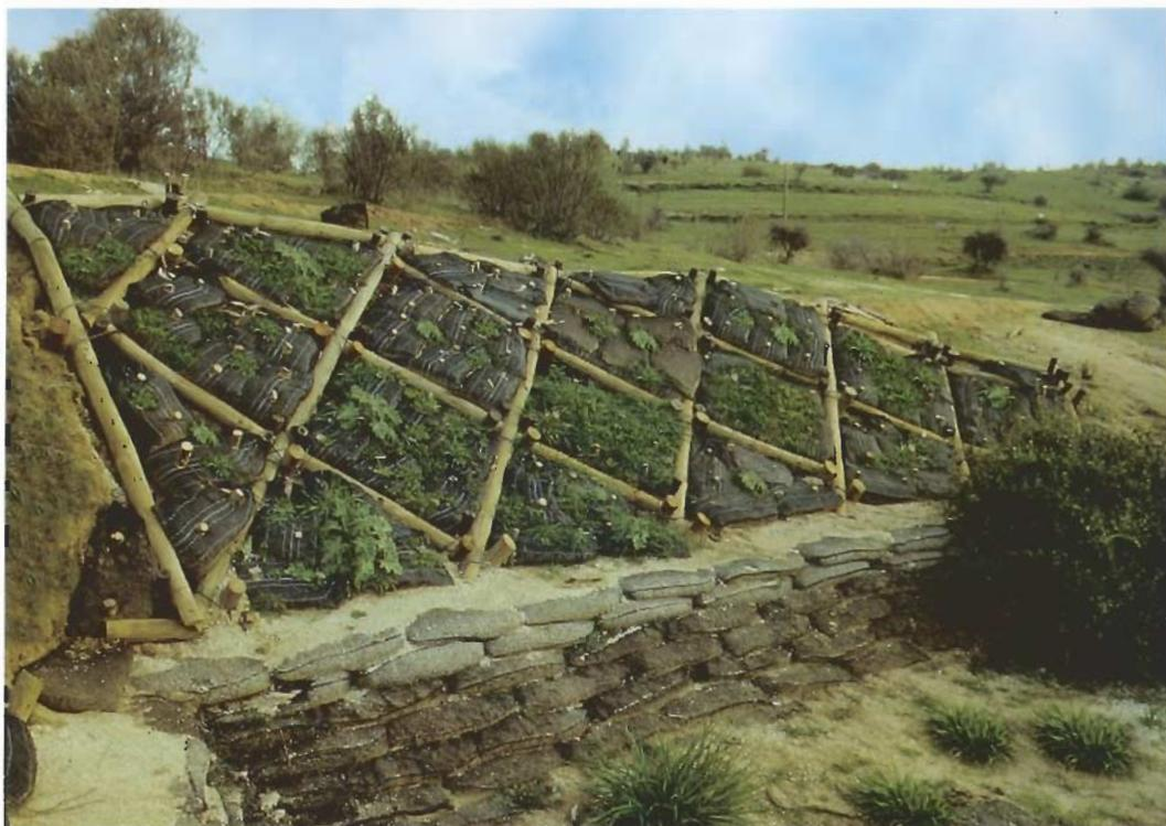
Vista general de una estructura de postes de madera y sacos de sombra para el control de erosión en taludes.
