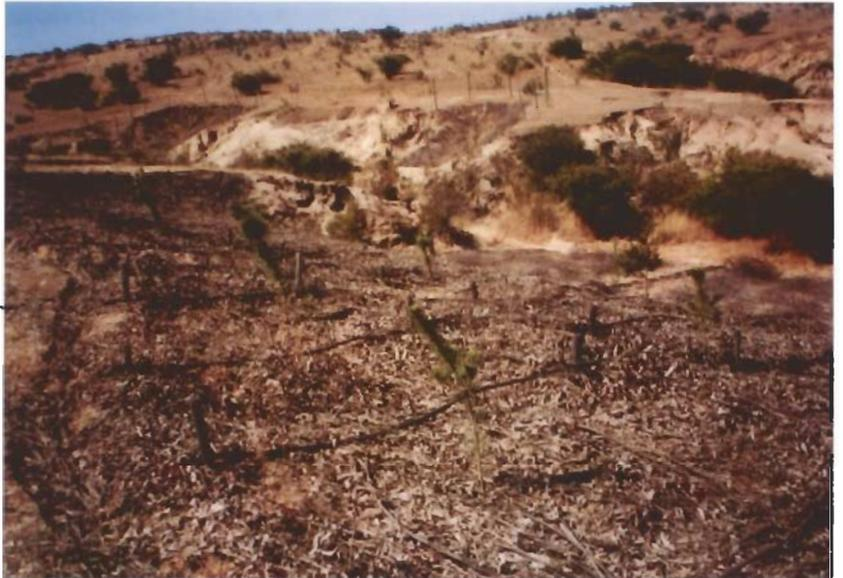
Vista general de tratamiento de cubierta con ramas de eucalipto en sectores con grado de erosión muy severa.
