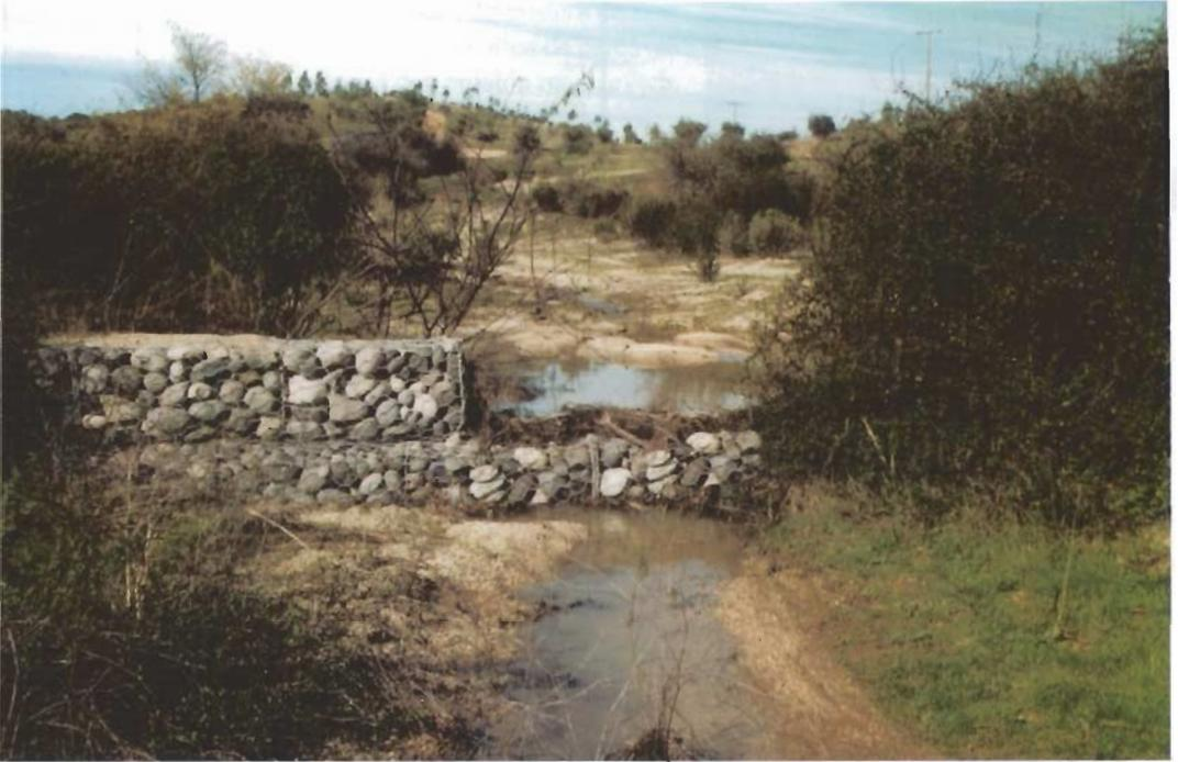
● Vista general de un dique de estructura gavionada para regular flujos hídricos en el cauce de la microcuenca.
