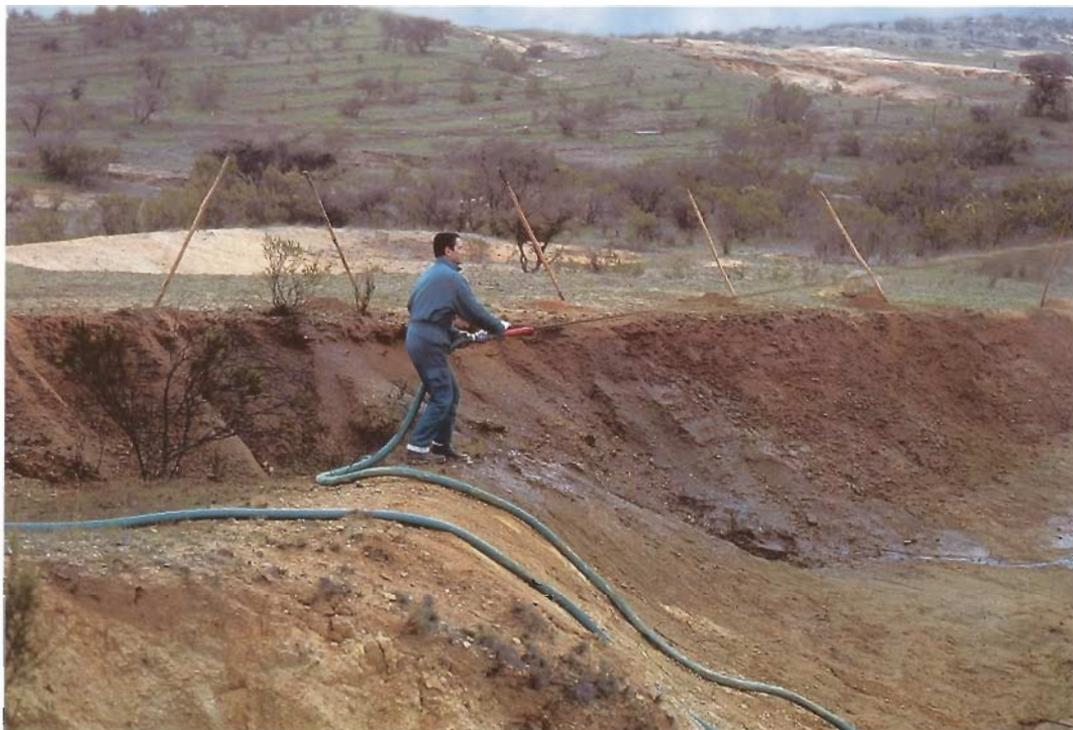
Primera fase de la hidrosiembra: aplicación de compuestos orgánicos y minerales, mulch, semillas y agua.
