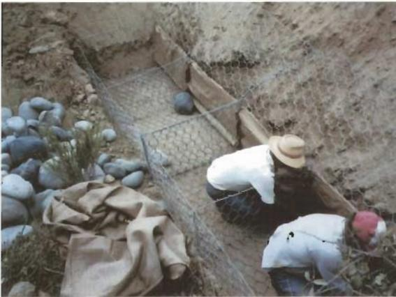
● Etapa de construcción de un dique de estructura gavionada con malla hexagonal de alambre, bolones de río y cubrimiento con sacos de yute en cara anterior.
