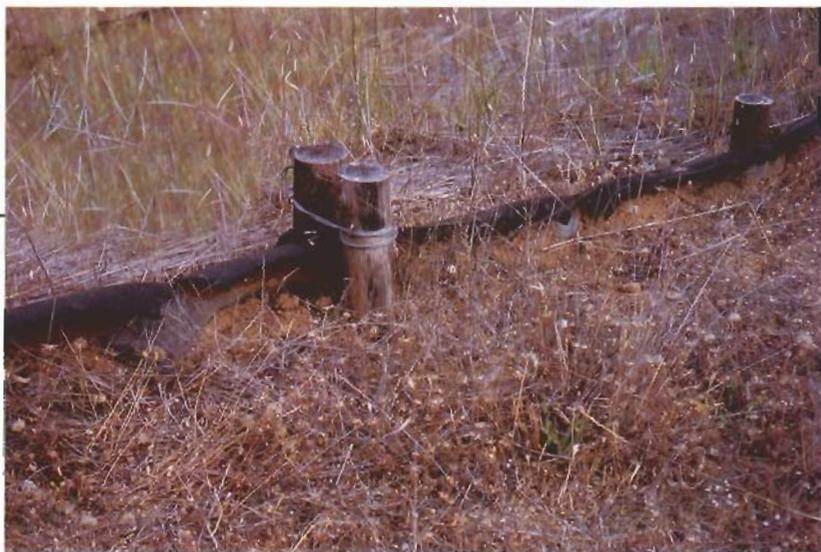
Vista detallada de tratamientos lineales con revestimientos de neumáticos
