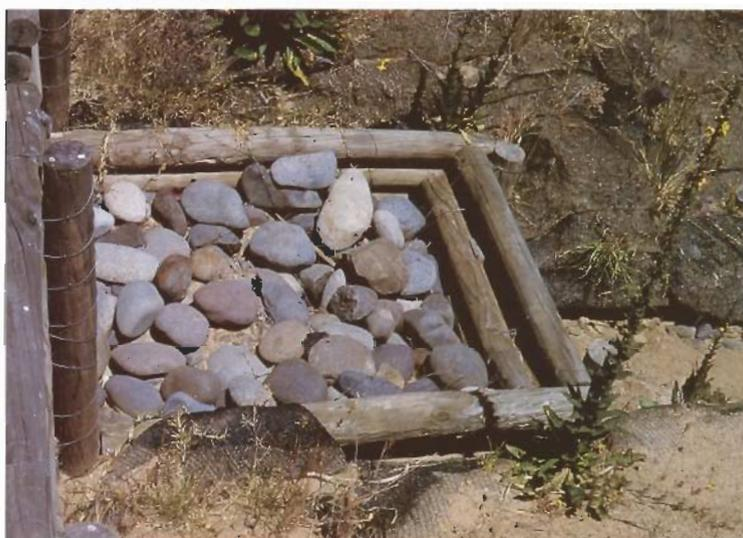
● Vista lateral de un dissipador construido con postes de pino impregnado y bolones de río.
