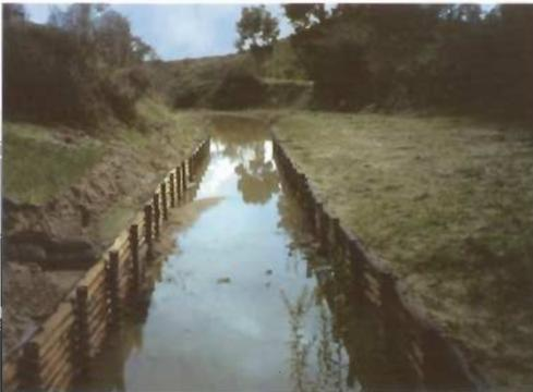
● Vista en perspectiva de tratamientos de control y estabilización con muros de postes de madera.
