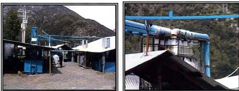
**Foto 16: Sistema de aireación y eliminación de gases no deseables y equipo de enfriamiento de agua para sala de incubación.**
