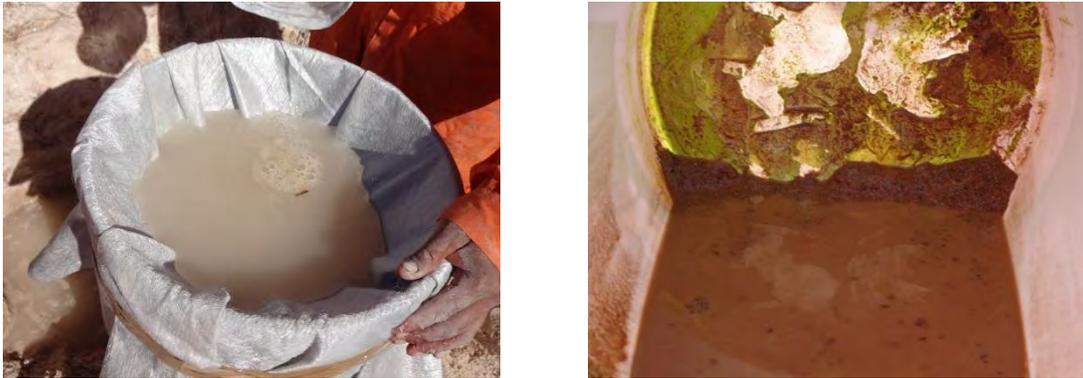
**Figura-10: Limpieza del agua del estanque mediante filtrado o decantación.**
