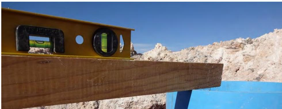
**Figura-11: Nivelación de lisímetro y estanque.**
