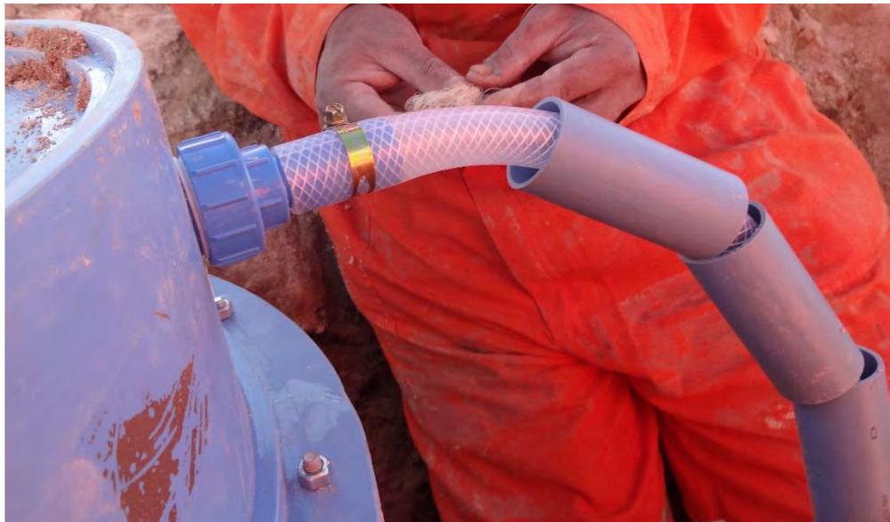
**Figura-9: Instalación de manguera de conexión.**
