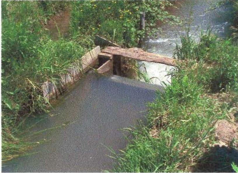
**Figura N° 12: Obra de distribución en mal estado**
