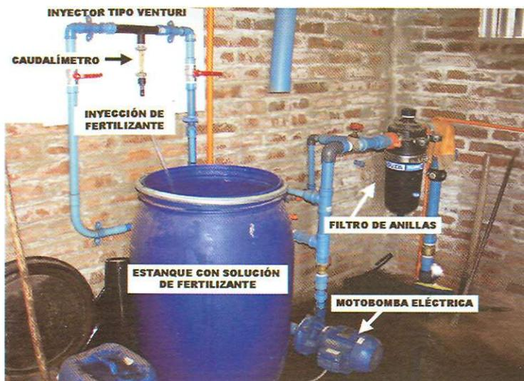
En las fotografías se muestran dos cabezales de riego por goteo con unidad de fertirrigación.
