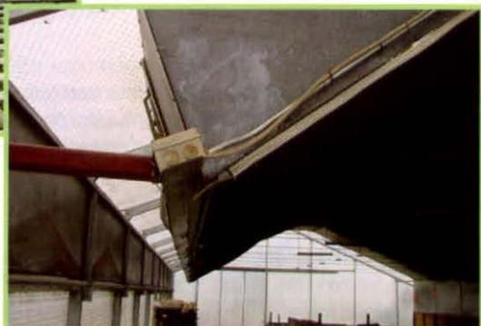
*Techo secador solar tipo invernadero (vista ventilador)*
